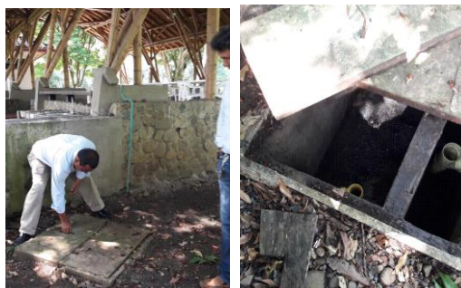
Fotografías 2. Vista de trampa de grasas junto al kiosco “Los Chimingangos”.
