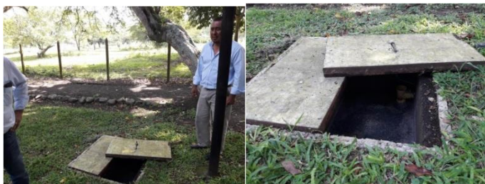
Fotografías 1. Vista de Trampa de Grasas, ubicada junto al sendero, en el costado sur occidental del Club, junto al Kiosco “Los Cedros”, que cuenta con su propio campo de infiltración
