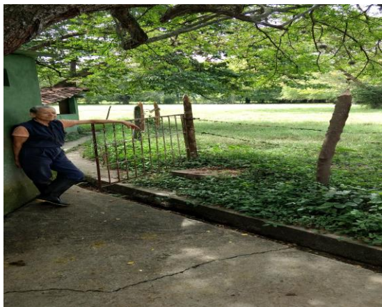
Sistema de tratamiento baterías zona ordeño
