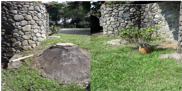
Fotografías 4. Trampa de grasas en el costado oriental del Club, junto a la derivación 6.3.1 del R. Pance, que cuenta con su propio campo de infiltración
