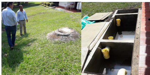
Fotografías 2. Vista de trampa de grasas junto al kiosco “Los Chimingangos”.
