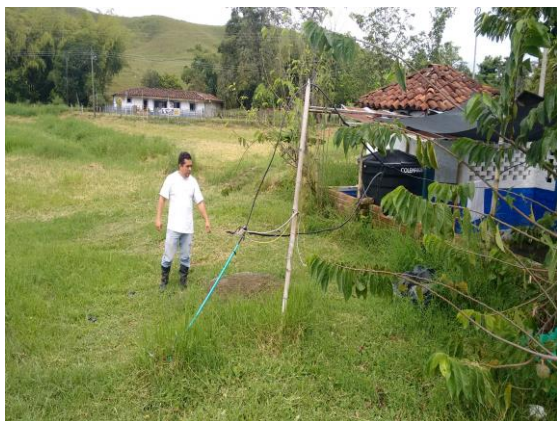
Figura (1) Figura 1 – Cámara recolección afluentes vivienda
