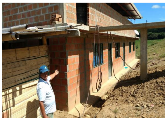
Figura 2 – Vivienda generación vertimientos líquidos
