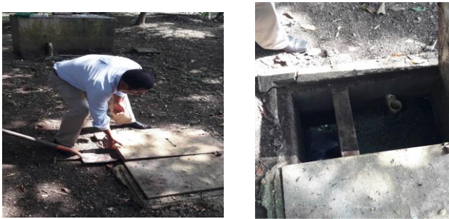
Fotografías 4. Trampa de grasas en el costado oriental del Club, junto a la derivación 6.3.1 del R. Pance, que cuenta con su propio campo de infiltración
