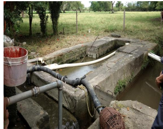
Estructura de transporte, recolección y bombeo de aguas residuales no domésticas
