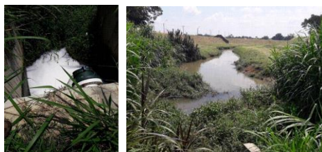
Fotografías 8. A la izquierda: se aprecia la tubería de descarga de las aguas tratadas, con su compuerta de chapaleta. A la derecha: el punto de descarga en el Z. Rosario.
