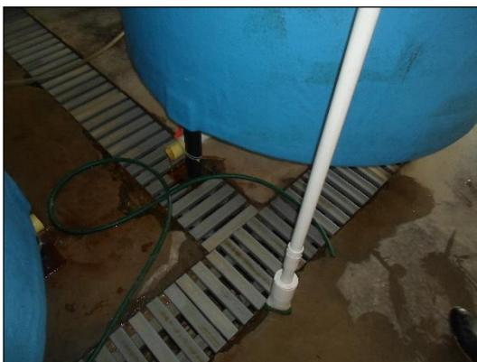
**Foto N° 2. Rejillas alrededor de sala de larvicultura para evacuación y conducción de aguas de lavado de tanques.**
