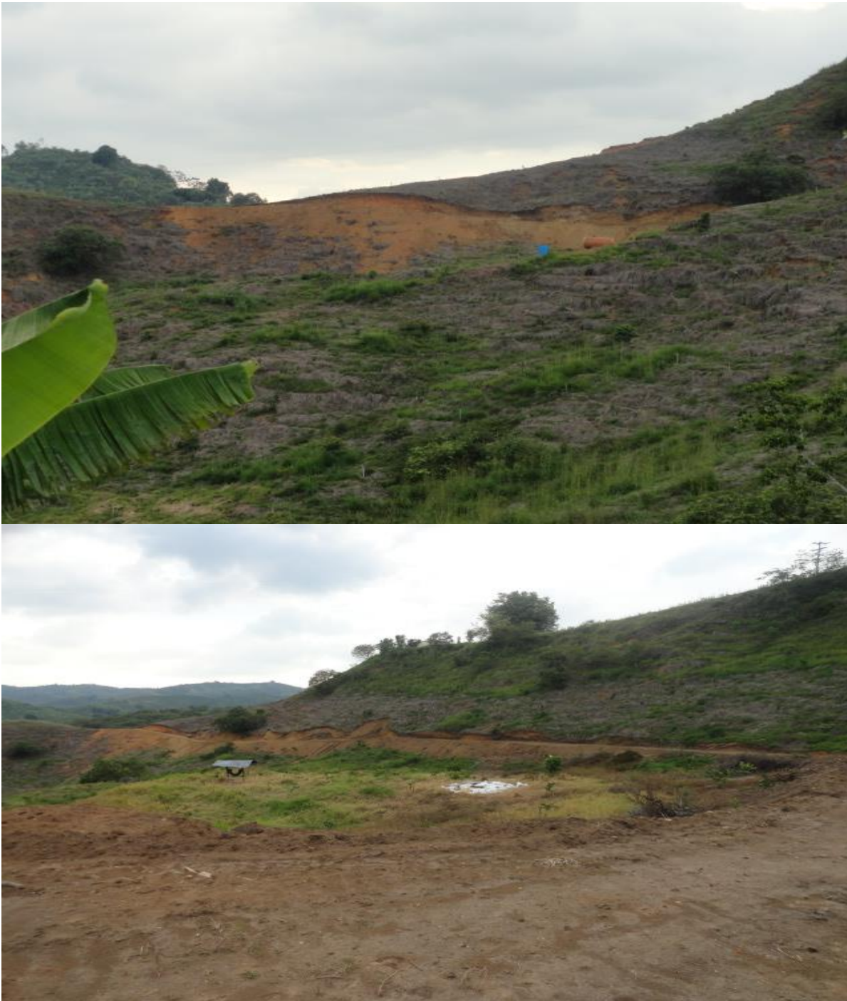
Fotos 1. Panorámica de la vía, donde se observa las pendientes.
