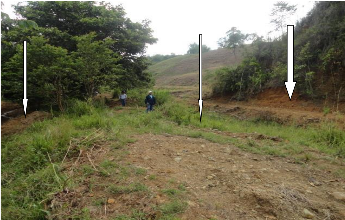
Foto 5. Las flechas indican a la izquierda la desviación del cauce, en el centro el antiguo cauce y a la derecha ampliación de la vía.
