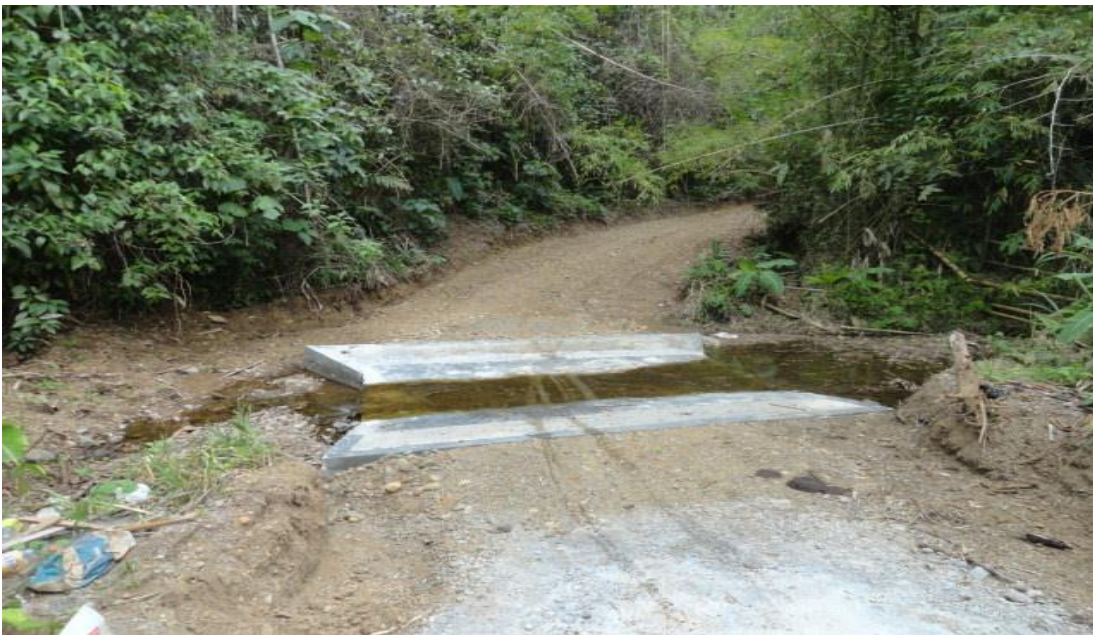
Foto 4. Obra construida para facilitar el paso de vehículos.
