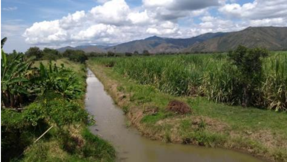
Canal colector para el bombeo de aguas lluvias del sector.
