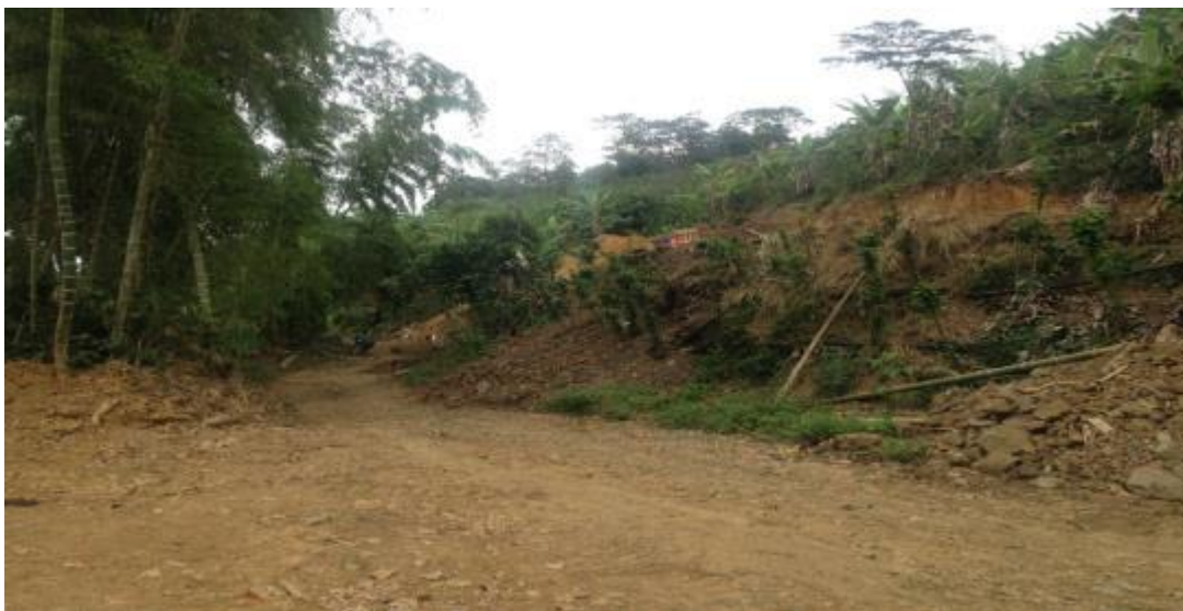
Foto No.2. La imagen muestra el sitio de la explanación, donde se intervino una zona de cafetal viejo, dentro del predio El Rubí, y parte del material resultante de dicha Actividad depositado sobre la cuneta interna de la vía a la Magdalena.
