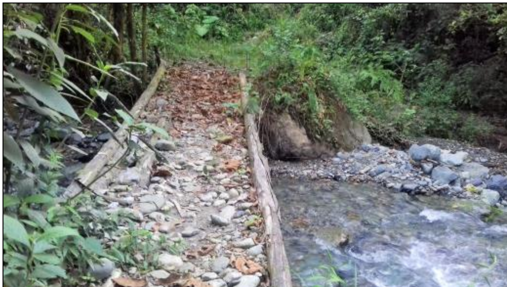
Figura 10. Puente construido en madera y piedra, ubicado sobre el cauce del río Riofrio, que conecta con la nueva apertura de vía.
