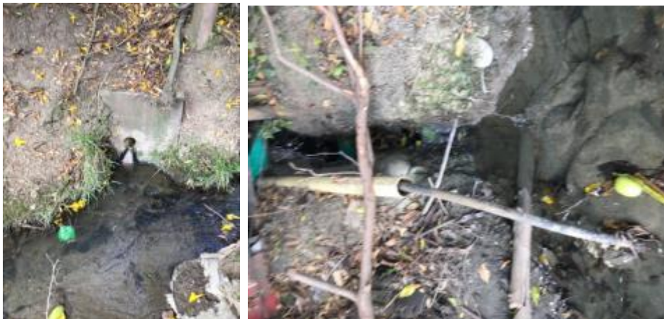
Fotografías 1 y 2. Vertimiento del sistema de tratamiento y vertimiento proveniente del lote contiguo a la EDS Terpel.
