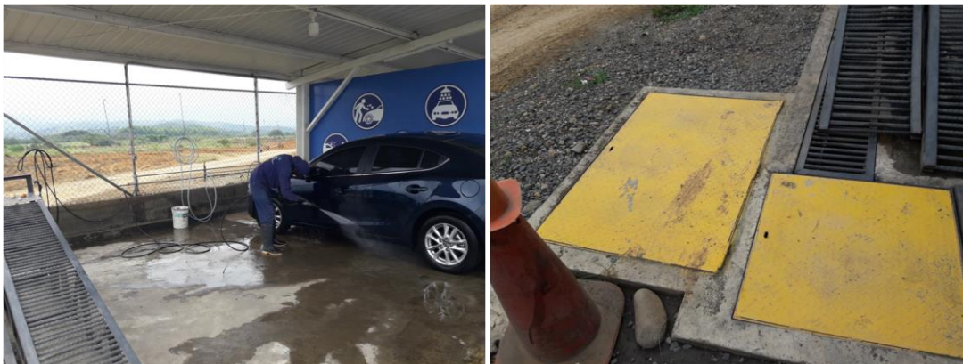
Fotografías 4. Vista del lavadero de carros, con su cárcamo, rejillas, canaletas perimetrales y desarenadores.
