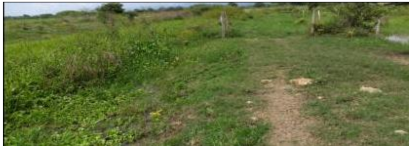
Canal colector de aguas lluvias, predio Aguasalada.
