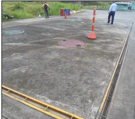
Foto N° 2. Rejilla perimetral existente alrededor de los tanque de almacenamiento de combustible.
