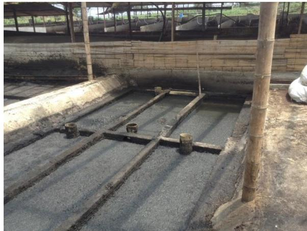
Fotos 3 y 4. En estas tomas se aprecia el sedimentador y el invernadero para el secado de la porcínaza generadas en la granja.
