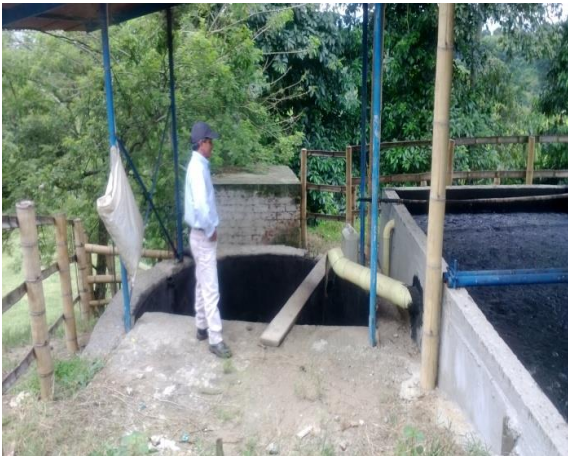
Fotos 3 y 4. En estas tomas se aprecia el sedimentador de la porcínaza generadas en la granja la Selva.
