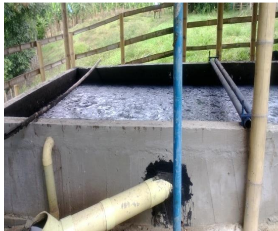
Fotos 3 y 4. En estas tomas se aprecia el sedimentador de la porcínaza generadas en la granja la Selva.
