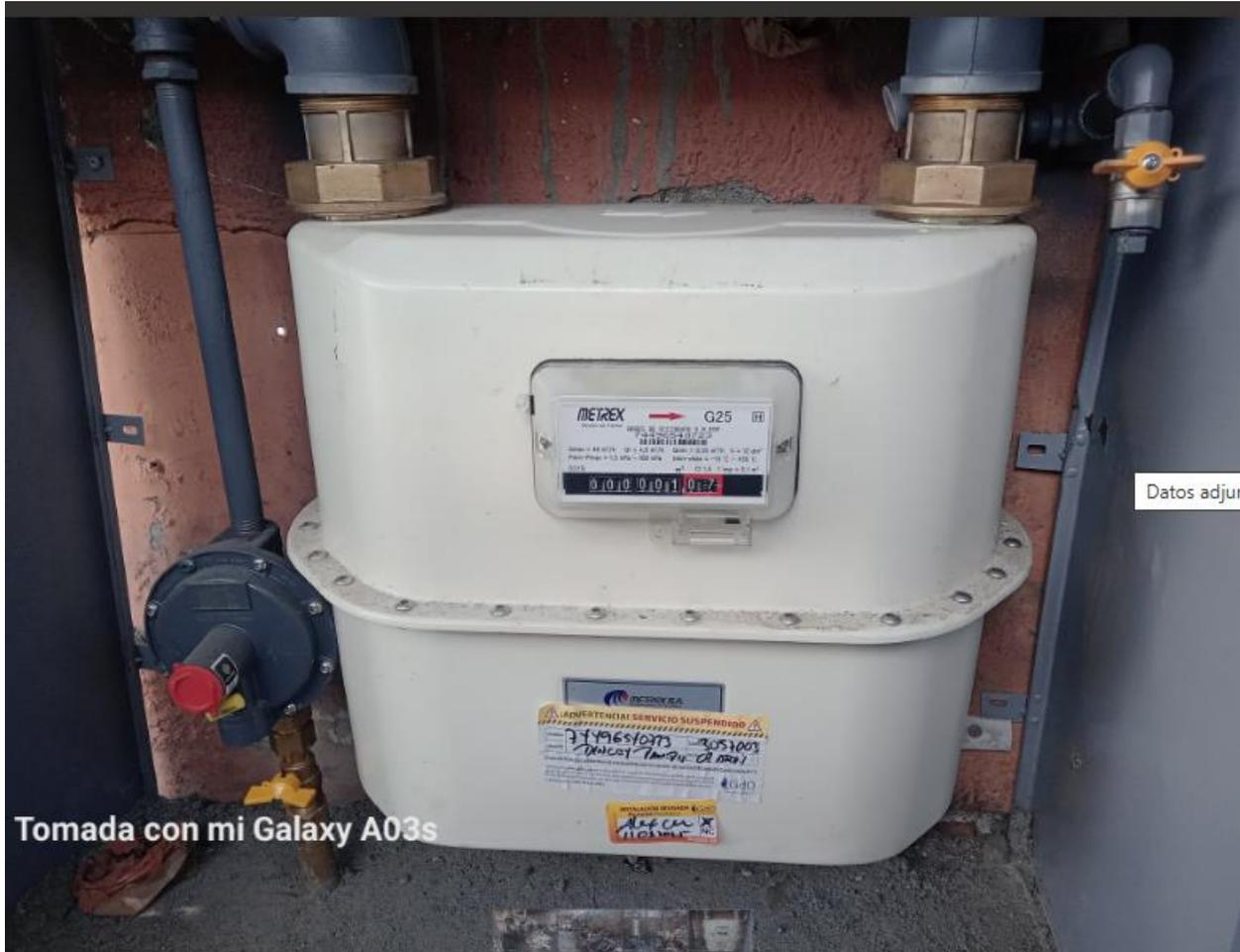
Foto No. 5. Medidor de gas domiciliario en estado inactivo.
