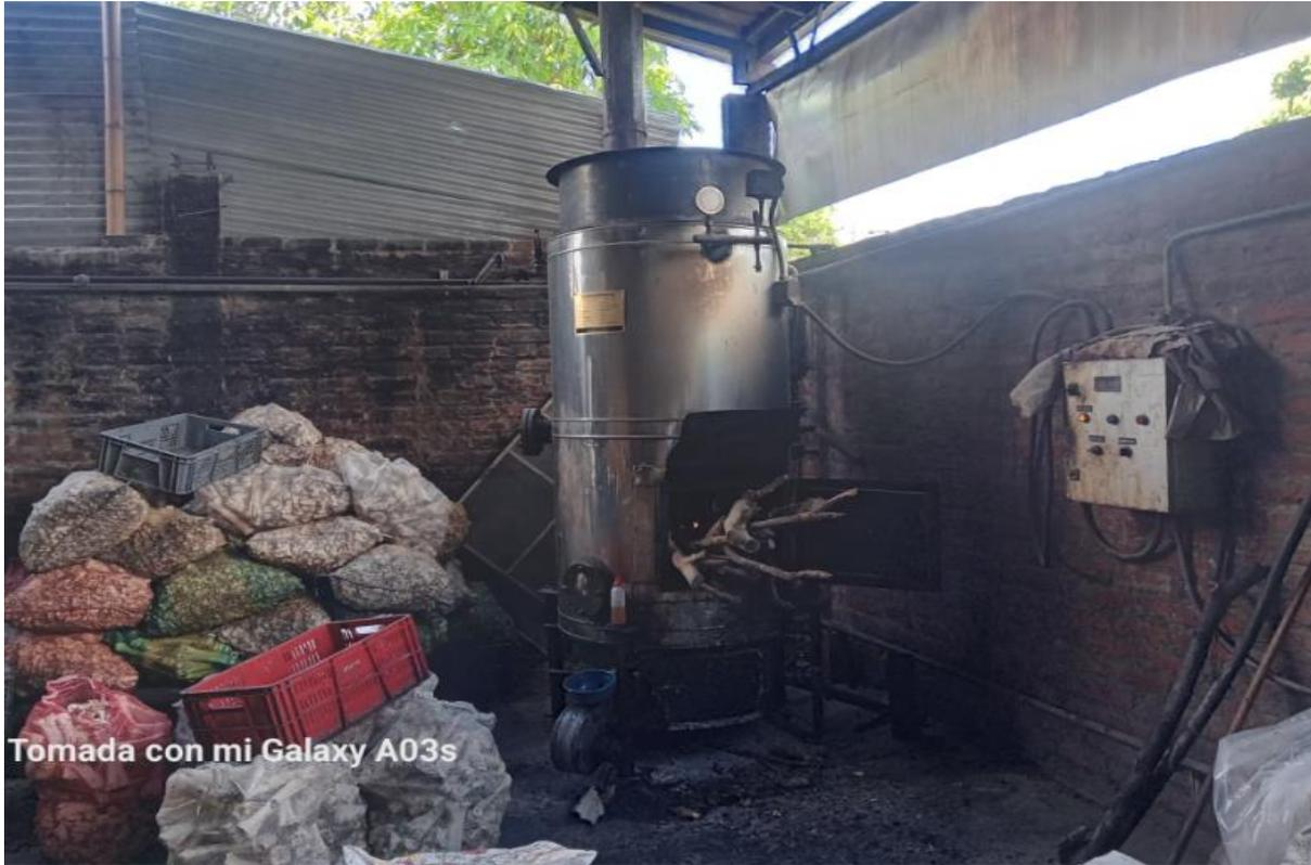
Foto No. 3. Nueva caldera instalada y tubería que proviene del medidor.
