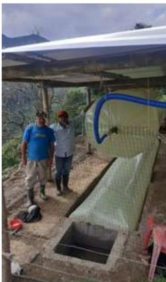
Foto 58. Biodigester instalado en la finca Agua Clara, cuenca Catarina-El Águila, Archivo CVC 2022
