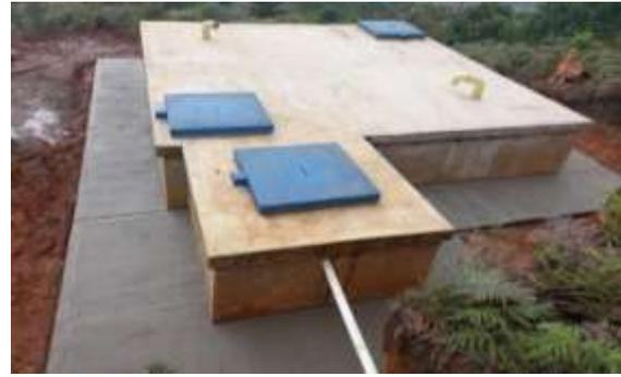
Foto 79. Desarenador y tanque de almacenamiento del sistema de abastecimiento. Archivo CVC.
