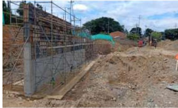
Foto 150. Avance en la construcción del muro de contención la obra de mitigación del riesgo – Riofrio. Archivo CVC. 2023
