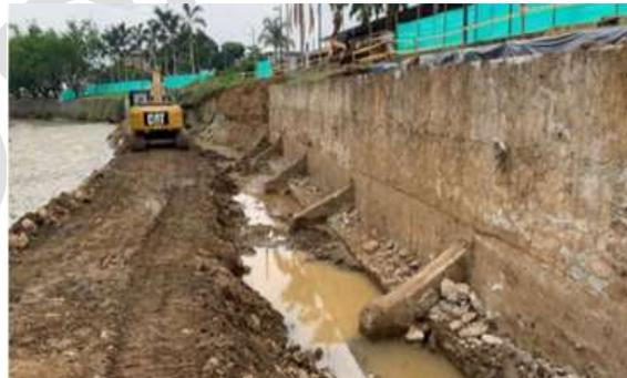
Foto 158. Avance en la construcción del muro de contención de la obra de Apoyo a la gestión del riesgo en la Zona Urbana de Santiago de Cali - Río Cali. Fuente: CVC, 2023.
