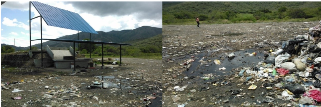
Imagen No. 5 y 6 – Tolva de descarga de Residuos con presencia de lixiviados (Arriba); Vista detalle de la generación, escorrentía e infiltración de lixiviados (Abajo). Fuente CVC, 2014.
