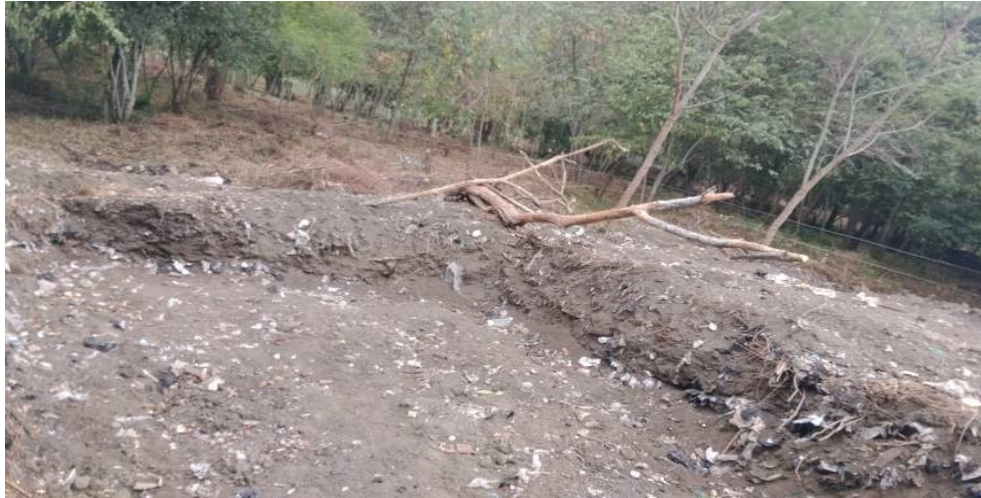
Imagen No. 11 – Vista parcial de área excavada adyacente a Zanjón Plaza Vieja. Fuente CVC, 2017.
