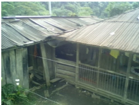
Foto 1. Aspectos de la vivienda a reparar
