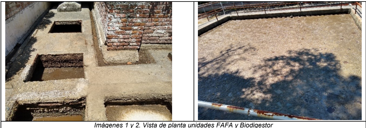
Imágenes 1 y 2. Vista de planta unidades FAFA y Biodigestor
