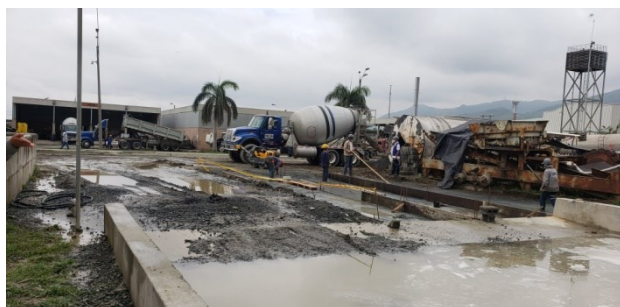
Foto 1. Adecuación zona de lavado de camiones Mixer y secado de lodos
