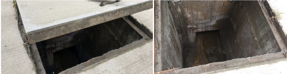
Fotos 5 y 6. Localización caja domiciliaria alcantarillado.
