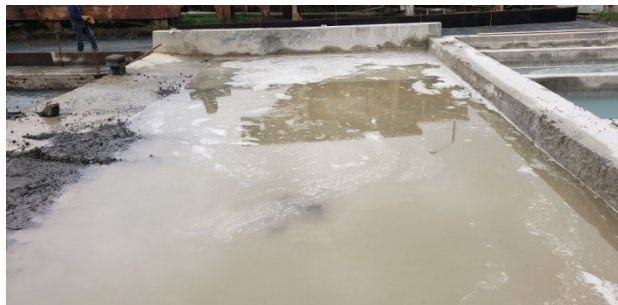
Foto 2. Canal de retención de lodos
