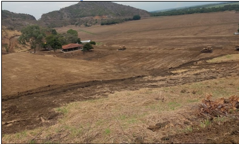
Imagen 2. Vista de la Terraza No. 2.
