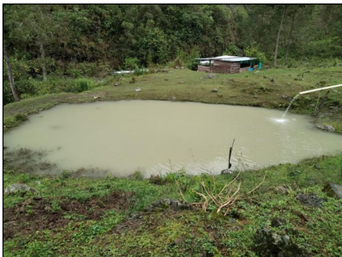
La construcción de un Tanque de cría de aproximadamente diez (10) metros de diámetro.
