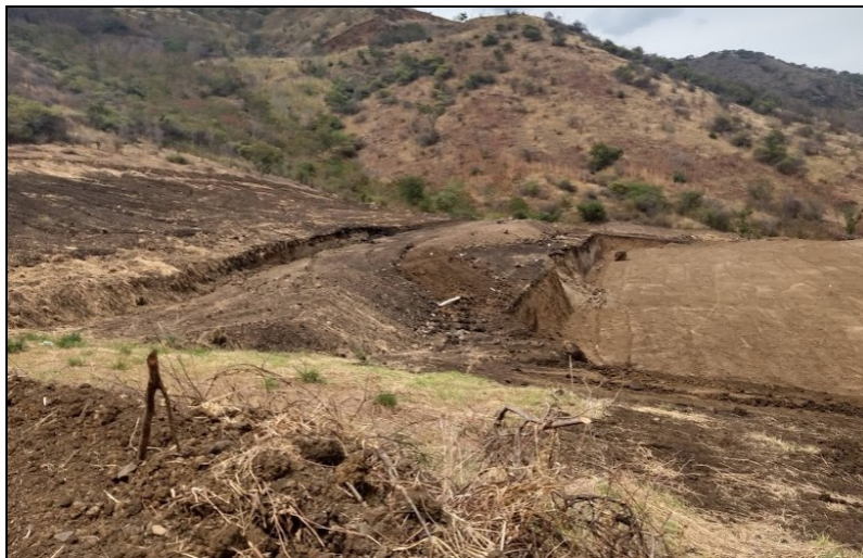
Imagen 3. Vista de tierra removida sobre terraza No. 1.
