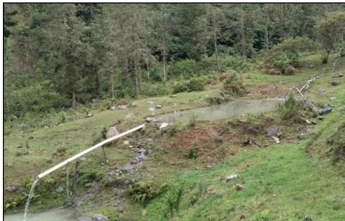
La construcción de un Tanque de producción de Alevinos, con dimensiones de 2 mts de ancho por 4 mts.
