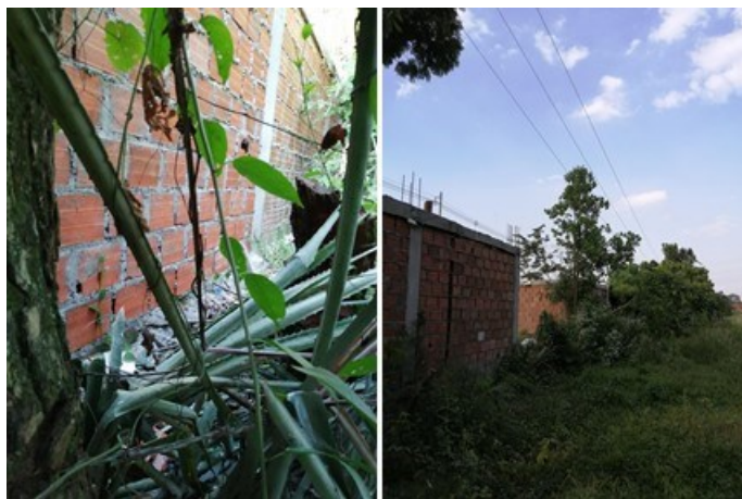
Imágenes 1 y 2. Evidencia del 13 de enero 2020 donde se observa la continuación de labores de construcción en el lindero del predio.
