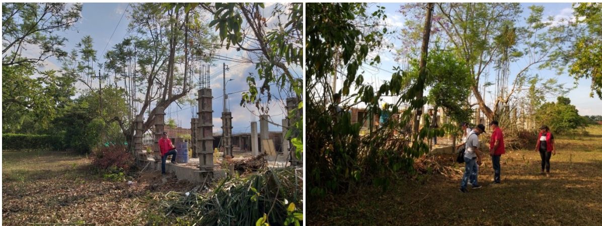
Imágenes 4 y 5 Tomadas el 12 de septiembre de 2019, donde se evidenciaba que las labores de construcción se encontraban en desarrollo de columnas sin paredes.
