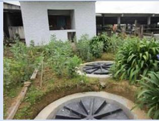
Foto 20. Bateria sanitaria, tanque séptico y filtro anaerobio. Sistema de Tratamiento de Aguas Residuales para la comunidad indígena de Mateguadua en el municipio de Florida.
