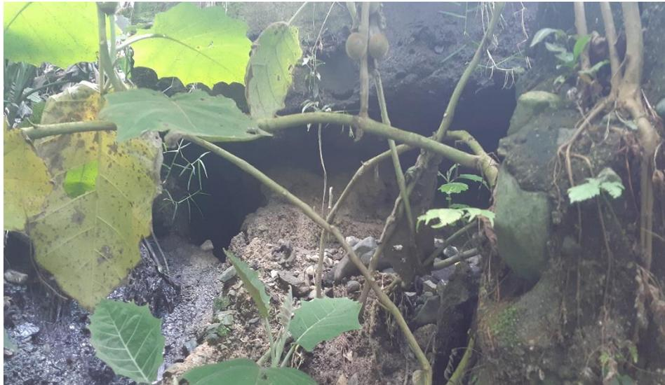
**Foto 3.** Se observa el proceso de socavación en la parte inferior del tanque y el vertimiento directo de aguas residuales de la red de alcantarillado de la vereda Alaska.
