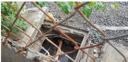
Foto 5. Aspecto general caja salida vertimiento hacia alcantarillado.
