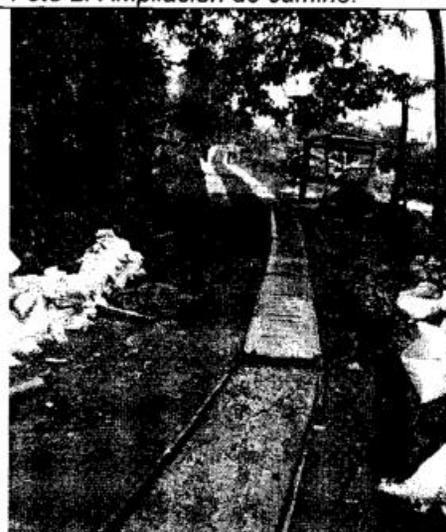
Foto 4. Construcción de huellas.
