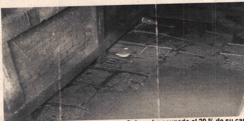
Tanque con capacidad de 12 metros cúbicos donde se almacenan los efluentes de la actividad porcícola.
