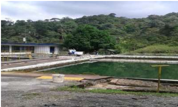
Foto 241. Seguimiento instalaciones de la planta de tratamiento del rio Escalerete.
