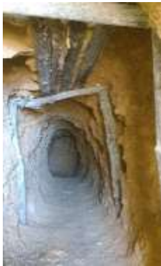
Foto 57. Socavones detectados en altos de Normandía, zona rural de Cali.
