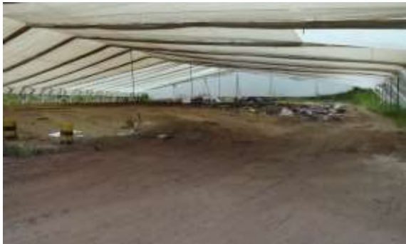
Foto 371. Cubierta celda de seguridad – Relleno de seguridad La Esperanza. Archivo CVC. 2018
