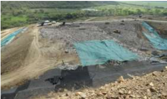
Foto 363. Relleno Sanitario Colomba - El Guabal. Archivo CVC. 2018
