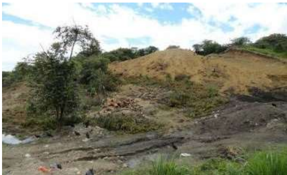
Foto 368. Proceso constructivo fase Este vaso 3 - Relleno Sanitario Regional Presidente. Archivo CVC. 2018
