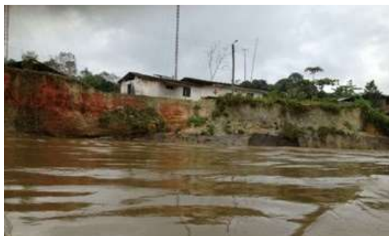
Foto 440. Desprendimiento de la orilla en la comunidad de Veneral del Carmen, río Yurumanguí, Archivo CVC. 2018.
