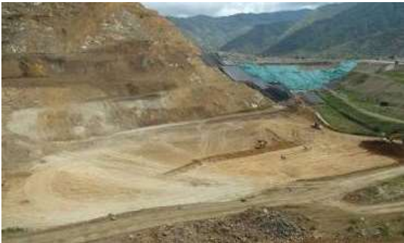
Foto 365. Adecuación del vaso 7 - Relleno Sanitario Colomba - El Guabal. Archivo CVC. 2018
