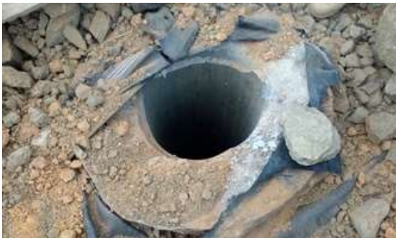
Foto 109. Verificación de las condiciones del pozo Vj-132, requerido para elaborar el concepto de sellado. Grupo Recursos Hídricos, DTA 2018.
