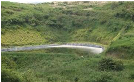
Foto 370. manto de control de erosión para el recubrimiento de taludes - Relleno Sanitario Regional Presidente. Archivo CVC. 2018
