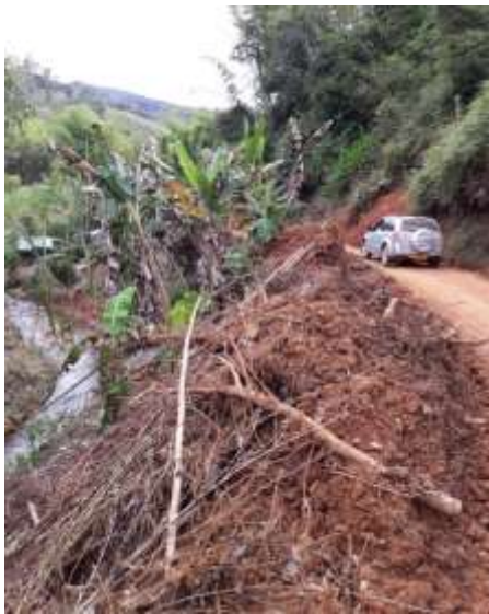
Foto 16. Deslizamiento compuesto con obstrucción del cauce por depositación de material excavado en la margen del drenaje, Grupo Gestión del Riesgo y Cambio Climático. DTA, 2018
