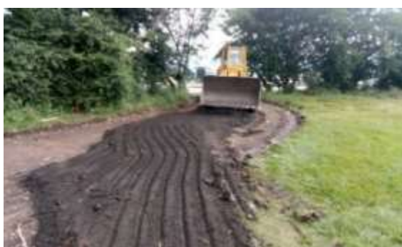
Foto 55. Seguimiento a apertura de una vía en el proyecto La Esneda del municipio de Buga.
