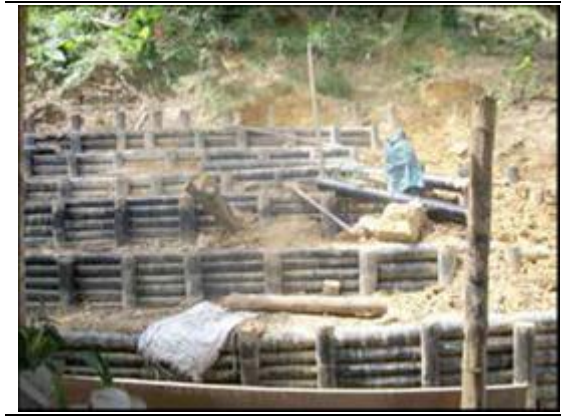
Obras de bioingeniería para estabilización de terrenos
