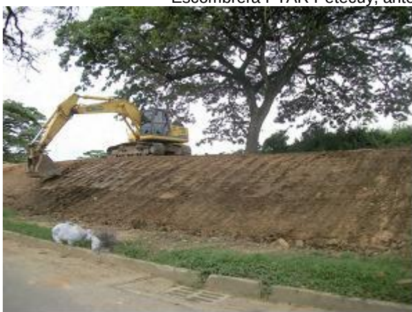
Recuperación mecánica del carillón
