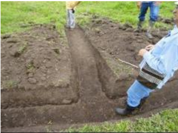
Construcción de zanja de coronación
