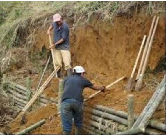
Construcción de trinchos
