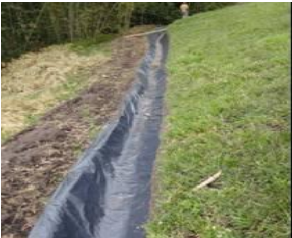
Construcción de zanja de coronación
