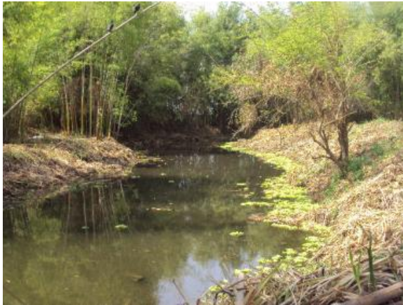
Tramo de humedal de los 12.000 m 2 descolmatado por el ingenio MAYAGÜEZ S.A.
