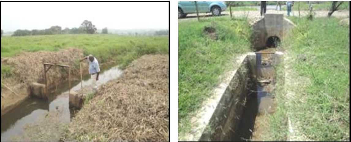
Construcción de estructuras de conexión hidráulica en los humedales Guarinó y Guinea del municipio de Jamundí
