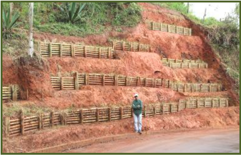
Trinchos y revegetalización para cotrol de erosión.
