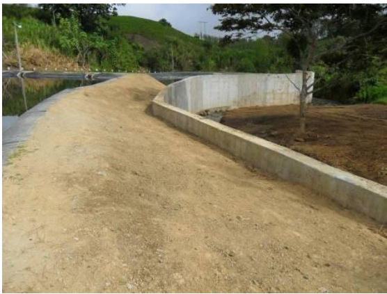
a) Limpieza de cauce b) Muro de protección contra inundaciones Obras de protección realizadas en lote PTAR Versalles
