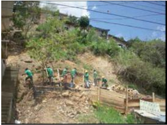
Obras de bioingeniería para estabilización de terrenos
