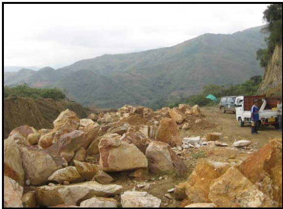
Extracción de materiales de construcción en vía de acceso interna.
