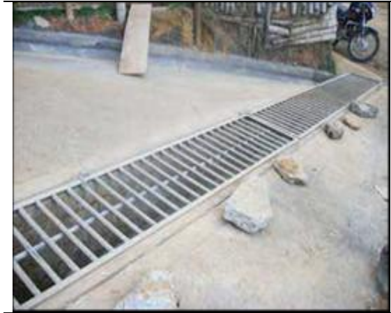
Obras para manejo de escorrentía
