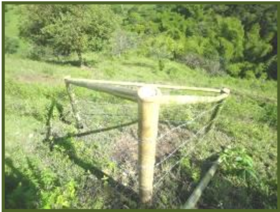
Construcción de chiquero, para sistema silvopastoril Calima Darien
