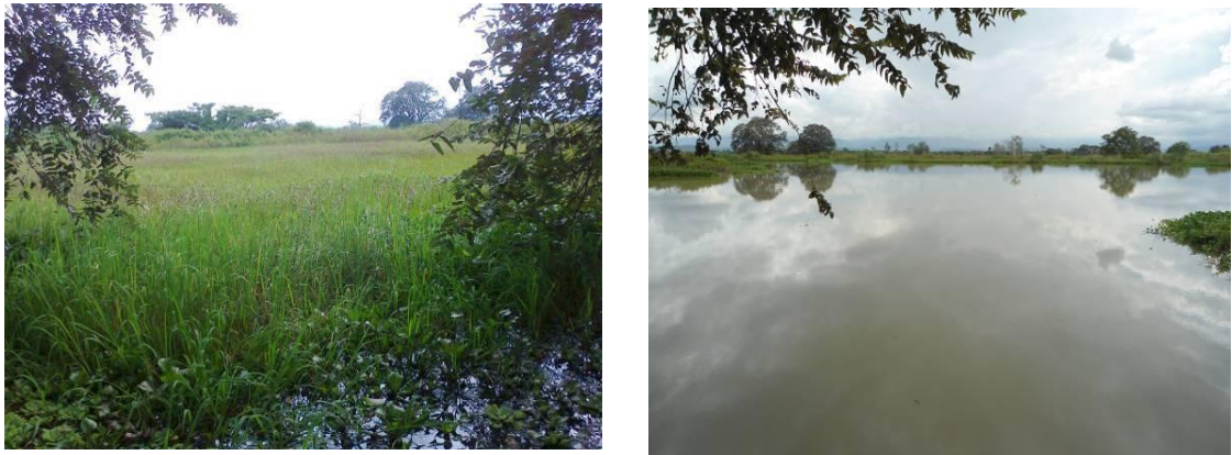
Antes del mantenimiento y Con mantenimiento
