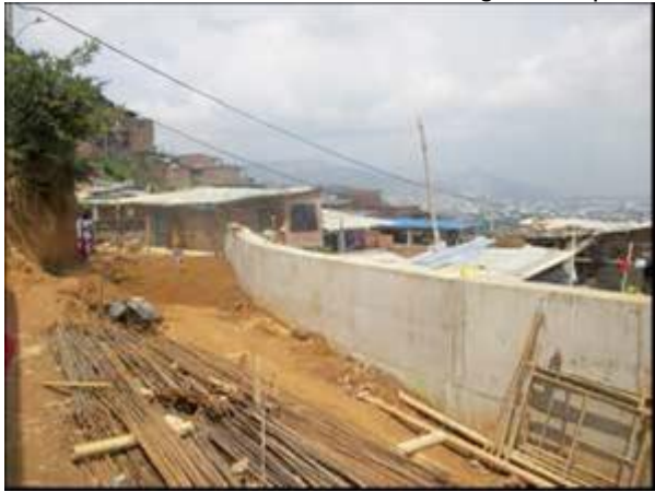
Construcción de muro de contención
