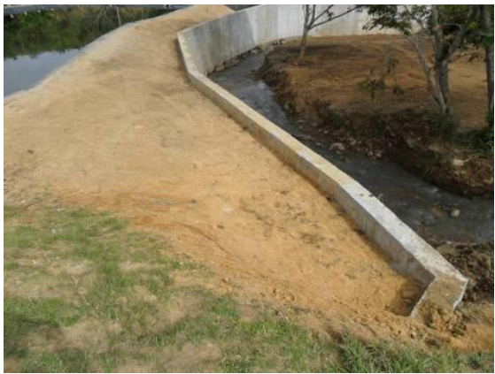
a) Limpieza de cauce b) Muro de protección contra inundaciones Obras de protección realizadas en lote PTAR Versalles
