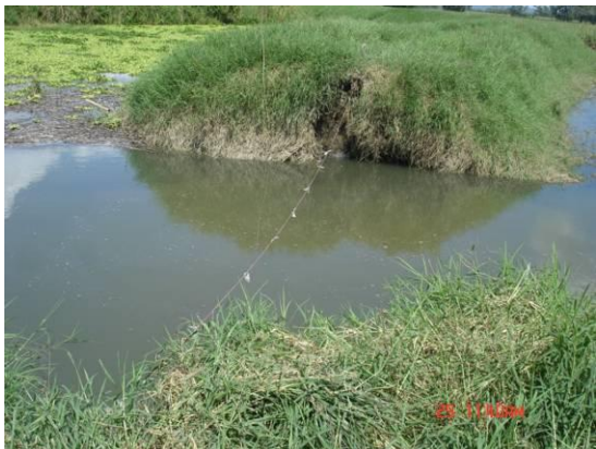
Daño en la vía
