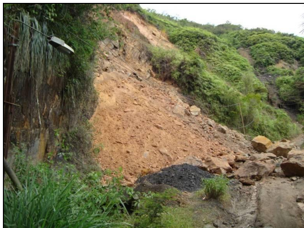
Presencia de minería artesanal de carbón cerca del río Meléndez, en condiciones antitecnicas y en terrenos inestables por movimientos en masa.
