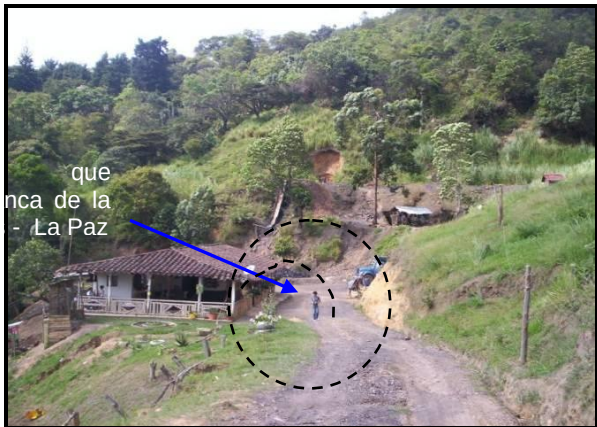
Vista general explotación ilegal sector Golondrinas – La Paz
