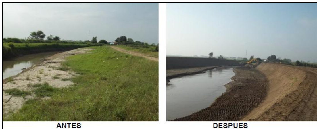
Figura 25. Intervención en el río Frayle, municipio de Palmira
