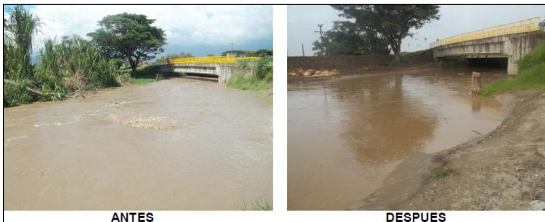
Figura 26. Intervención en el río Bolo, municipio de Palmira
