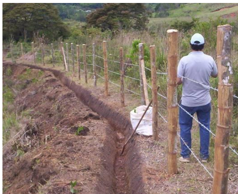
Zanja de coronación para canalización de aguas y aislamiento de área afectada por erosión. Caja recolectora de agua. Municipio de Dagua- Corregimiento El Queremal
