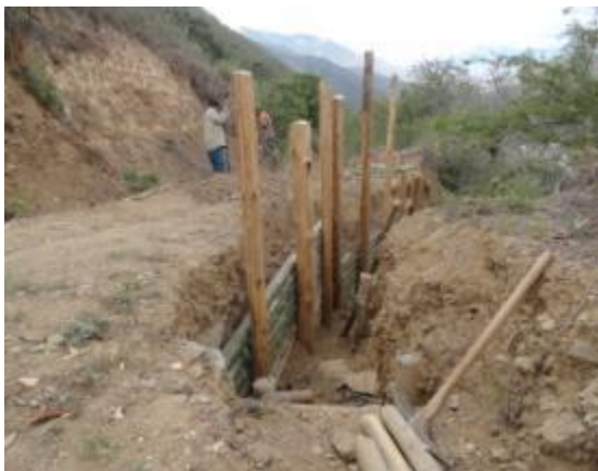
Estabilización de talud y manejo de aguas a través de disipadores
