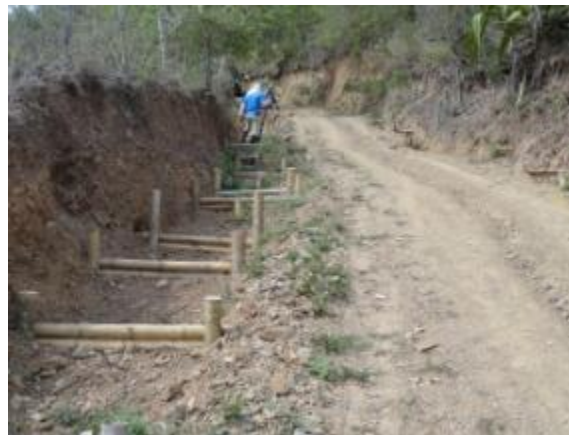
Estabilización de talud y manejo de aguas a través de disipadores
