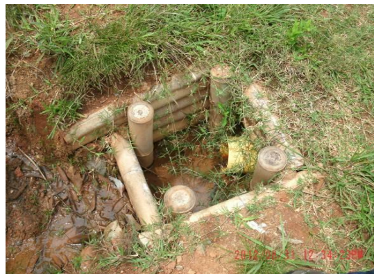
Zanja de coronación para canalización de aguas y aislamiento de área afectada por erosión. Caja recolectora de agua. Municipio de Dagua- Corregimiento El Queremal
