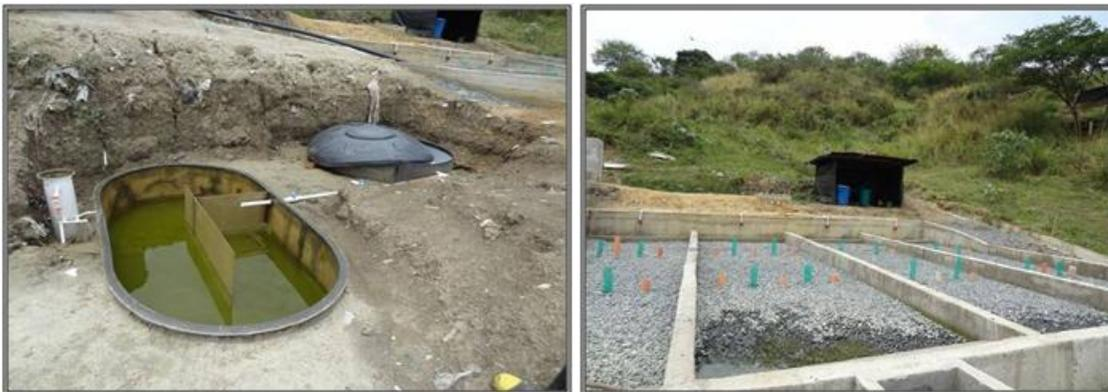
**Monitoreo:** Se realiza la caracterización tanto de pozos de monitoreo como del afluente y efluente del sistema de tratamiento de lixiviados
