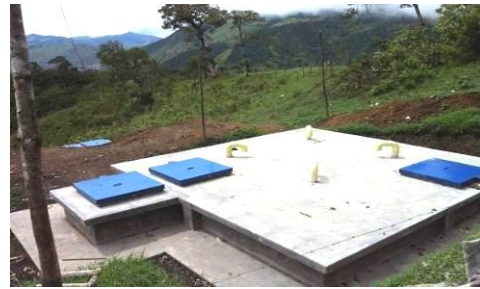
Tanque de almacenamiento
