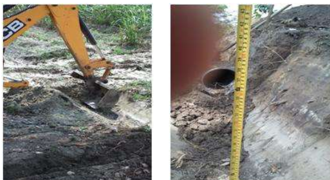
-Mantenimiento del drenaje externo.
