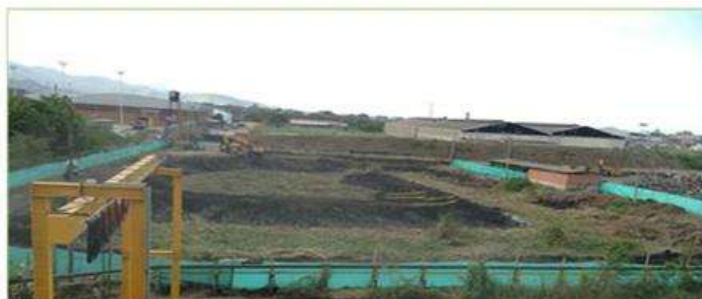
DIACO S.A. Vista general de adecuación del área para construcción de la celda de seguridad, Julio de 2013. (Antes)
