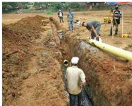
Instalación de tubería y tapado de zanjas
