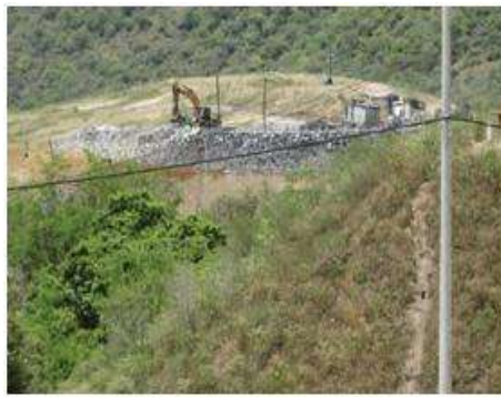
Frente de operación actual – relleno sanitario regional Colomba – El Guabal
