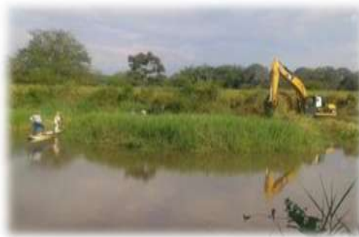
Mantenimiento humedal la Guinea - Jamundí
