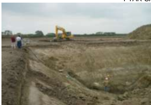
Excavación reactor UASB
