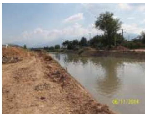
Descolmatación del Humedal
