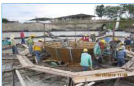
Clarificador – cimentación y fundición de la tolva
