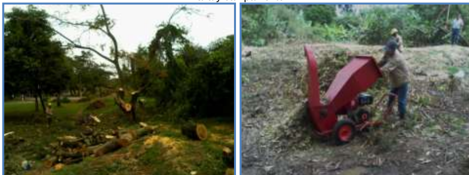
Corte y retiro de árboles y arbustos
