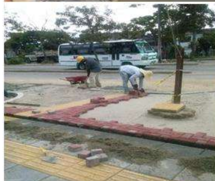
Construcción andenes y senderos
