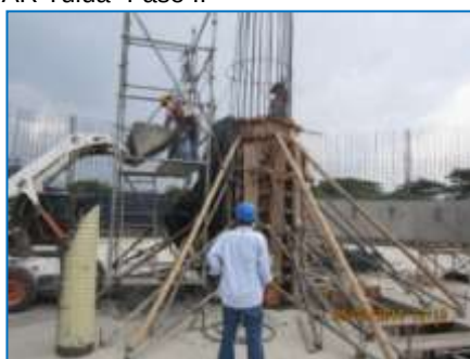
Filtro percolador- fundición de la columna central, muros y vigas canal percolador
