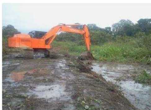
Excavación a máquina
