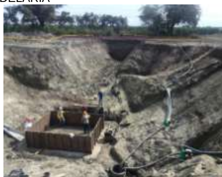
Excavación Estructura de entrada
