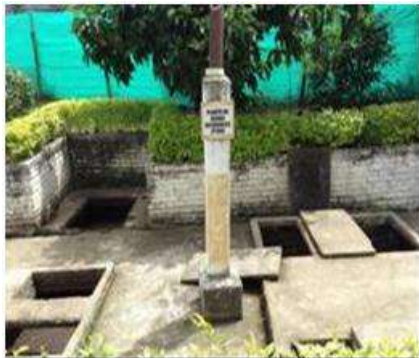
Se observa el filtro anaerobio del sistema de tratamiento de aguas residuales de la planta de sacrificio del municipio de Tuluá, administrada y operada por la empresa FRIGOTIMANÁ.
