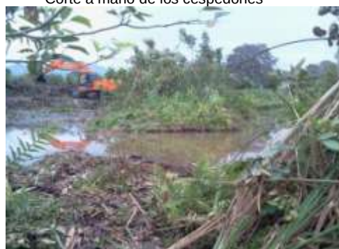
Bloques de cespedon que son acercados a la retroexcavadora para poder ser excavados
