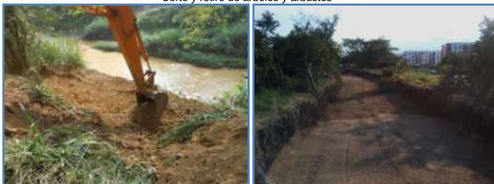
Excavaciones de berma y cimentación, y relleno para cimentación del dique
