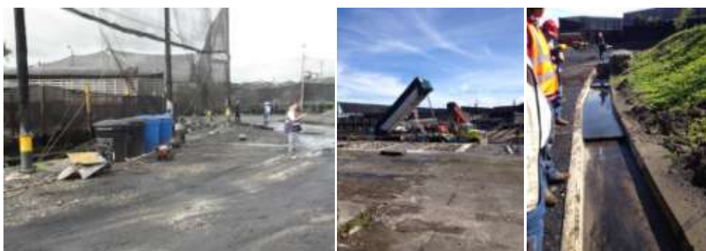
Barreras sintéticas para evitar migración de material particulado a la zona urbana
