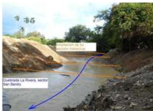
Obsérvese la ampliación de su sección hidráulica de la quebrada La Rivera frente al predio San Benito frente a la Clínica María Ángel, la empresa CETSA, y predios ribereños del sector.
