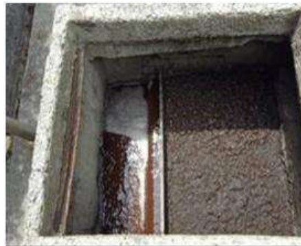
Se observa el filtro anaerobio del sistema de tratamiento de aguas residuales de la planta de sacrificio del municipio de Tuluá, administrada y operada por la empresa FRIGOTIMANÁ.
