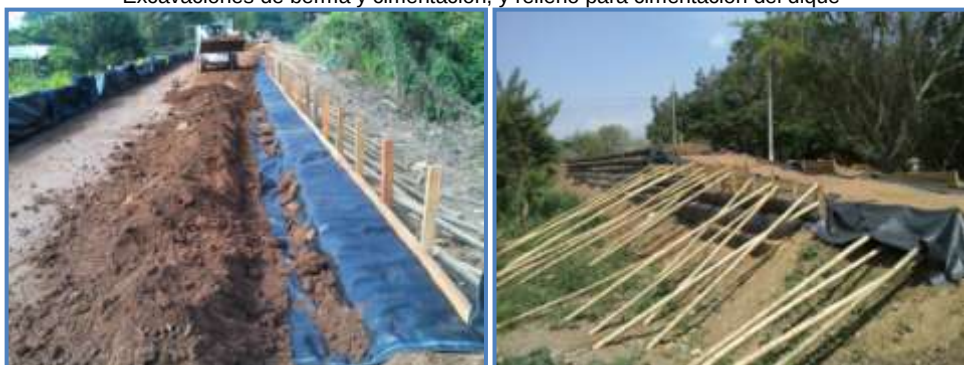
Construcción de dique en MSR
