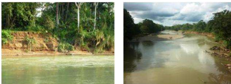
Erosión marginal en el río Dagua
