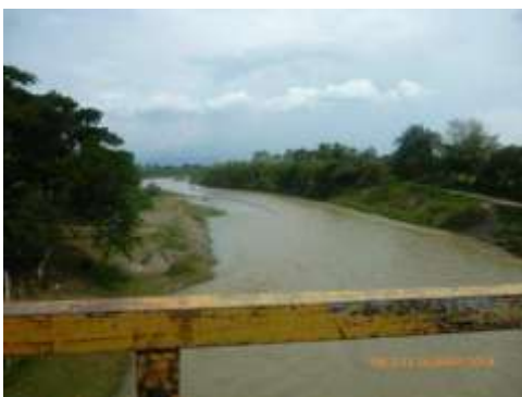
Estado del río Riofrío, posterior a intervenciones realizadas, donde se verifica ampliación de capacidad hidráulica.
