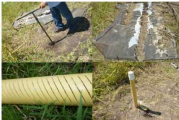
Construcción de pozos de monitoreo
