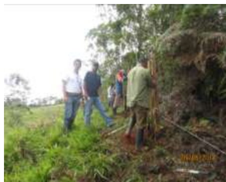
Vista de predio en desarrollo de labores de instalación de aislamientos de protección (hincado de postes).
