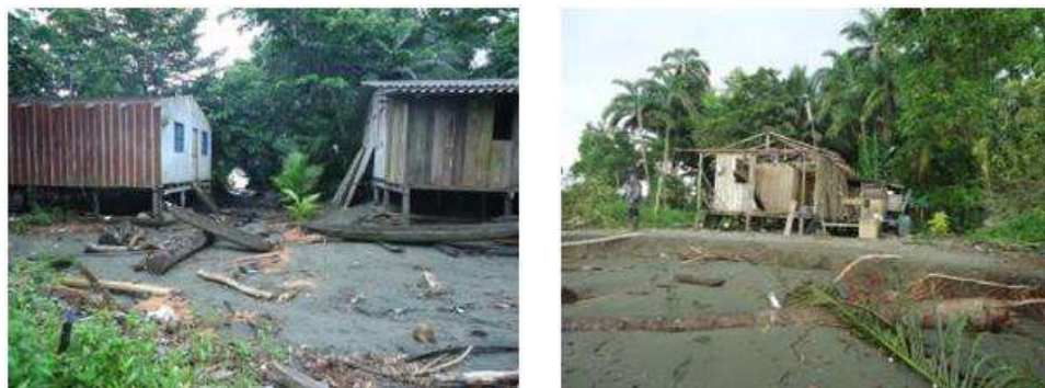
Viviendas afectadas por la erosión costera
