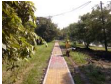
Sendero construido en adoquín
