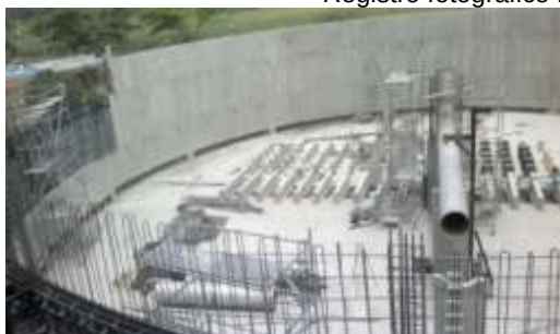
Filtro percolador- fundición de la columna central, muros y vigas canal percolador
