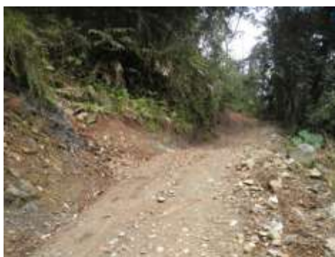
Panorámica de la adecuación de una vía en el predio La Abadía.
