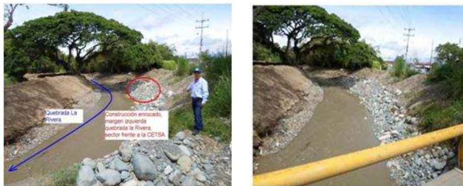
Obsérvese el encochado que se está realizando frente a la empresa CETSA, Puente San Benito, margen izquierda predio Santa Clara.
