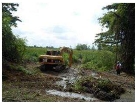
Extracción actual de macrófitas acuáticas con maquinaria y apoyada con corte manual de enea
