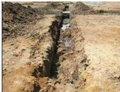
Apertura de zanjas
