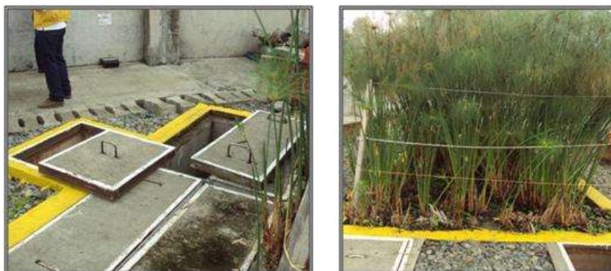
Sistemas de tratamientos de aguas residuales domésticas, con pulimiento con depuración fitopedológico.
