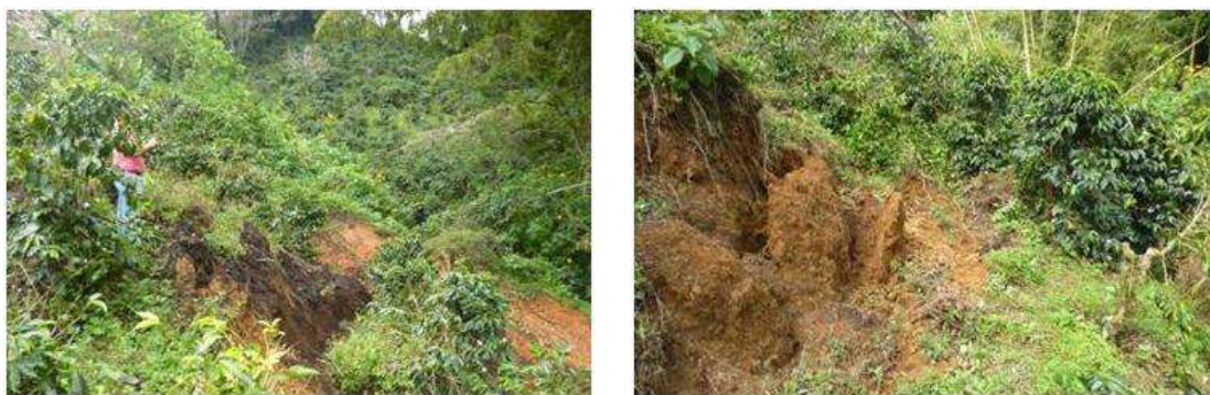
Detalle del hundimiento del terreno desplazándose progresivamente.
