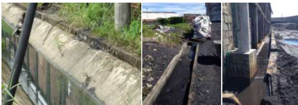
Canales Perimetrales para recolección de aguas lluvias del área del patio
