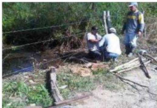
Seguimiento a la actividad de reparación de cercos.
