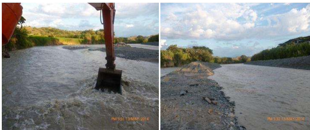
Momentos de intervención sobre las barras de materiales de arrastre, buscando centrar el cauce del río en un canal de mayor amplitud, mitigando el riesgo de afectaciones marginales y desbordamientos.
