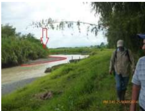
Barra ubicada frente a espolones, situación que genera mayor “entubamiento del cauce y por ende, direccionamiento hacia la margen derecha (debido a la curvatura del río en el sector).
