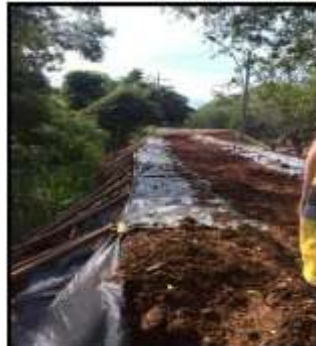
Construcción dique en tierra en Centro recreacional COMFANDI
