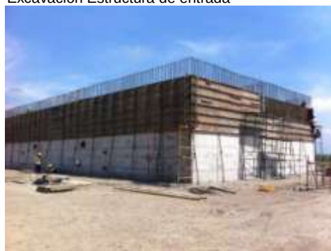
Reactor UASB (Encofrado y aceros)
