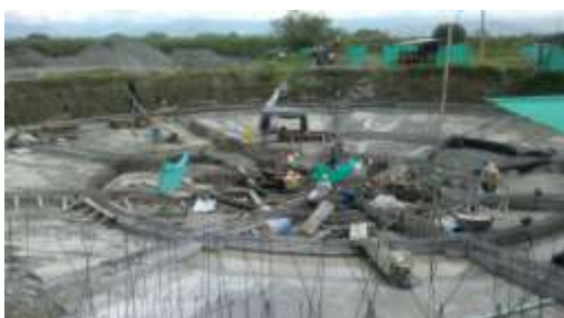
Clarificador – cimentación y fundición de la tolva
