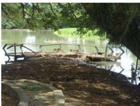
Reparación y mantenimiento de mirador
