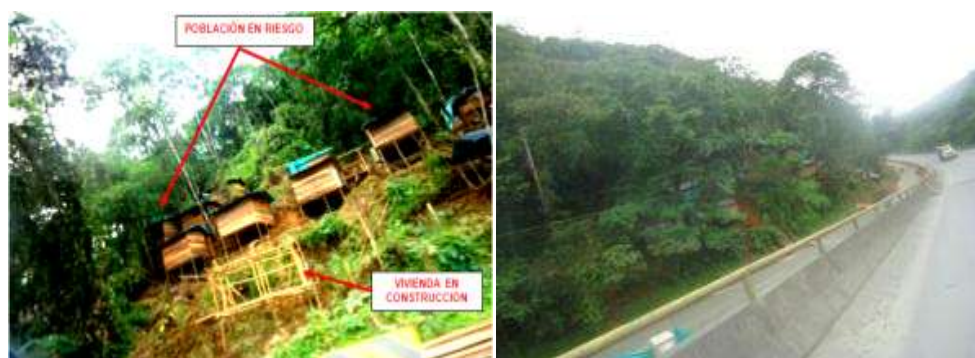
Viviendas en zona de amenaza por deslizamiento
