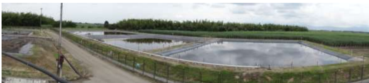
Reservorios de almacenamiento de vinazas – ingenio Manuelita
