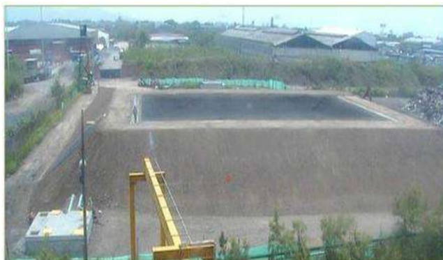
DIACO S.A. Vista general de la celda de seguridad construida para la disposición de escorias. Abril de 2014. (Después)
