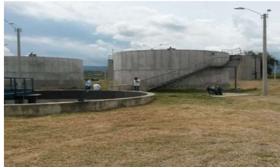
Foto 109. Planta de Tratamiento de Aguas Residuales de la cabecera municipal del municipio de Argelia.
