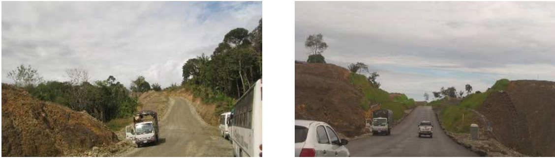
Foto 117 Cambio cobertura y uso del suelo, vía al puerto de Aguadulce, Buenaventura
