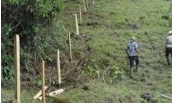
Foto 45. Labores de instalación de aislamientos de protección predio Belmonte, cuenca del río Pescador, municipio de Bolívar (Convenio 088-2016 CVC-Fondo Agua
