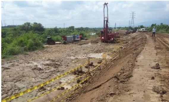
Foto 304. Realce y reforzamiento del Jarillón abscisa K6 + 100. Archivo CVC.
