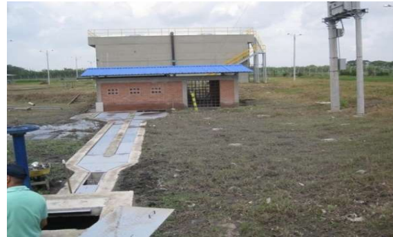
Foto 107. Estructuras entrada PTAR y Tratamiento preliminar
