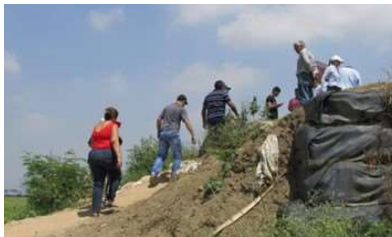
Foto 295. Recorrido por el sistema de protección contra posibles inundaciones con la comunidad de Ciudad del Campo, Corregimiento de Juanchito, Palmira- UGC Bolo Frayle Desbaratado
