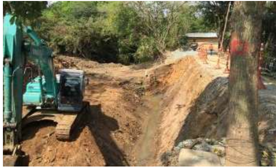
Foto 321 Excavación para muros
