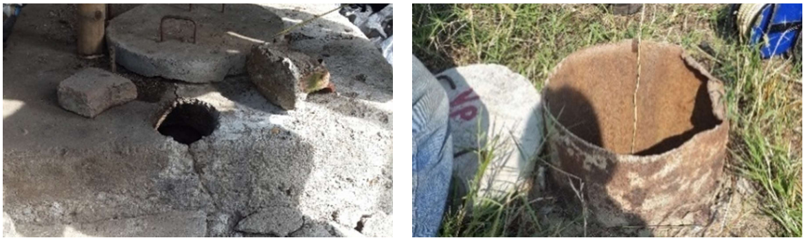
Foto 59. Trabajo de campo para la verificación de las condiciones de los pozos abandonados, requerido para elaborar los conceptos de sellado. Fuente: Grupo Recursos Hídricos, DTA. 2016
