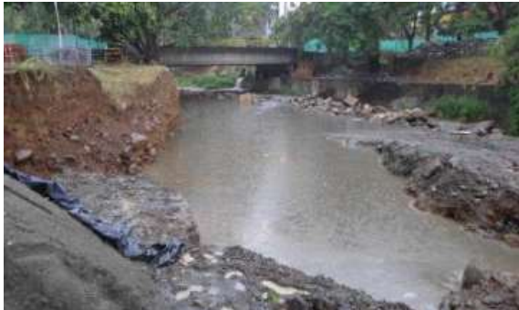
Foto 317 Excavación margen derecha
