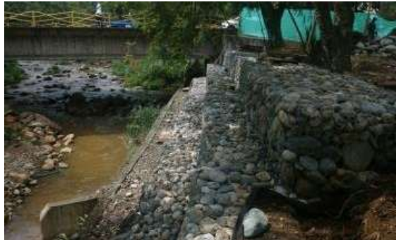
Foto 318 Muro en gaviones margen izquierda
