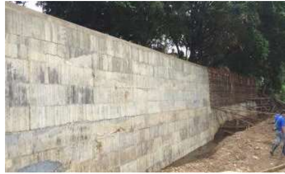
Foto 322 Construcción muro en concreto
