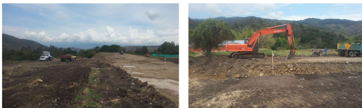
Foto 10. Proceso de explanación y nivelación de suelo para la ampliación de la Granja Avícola Saratano en la vereda La Magdalena Municipio de Buga. DAR Centro Sur.
