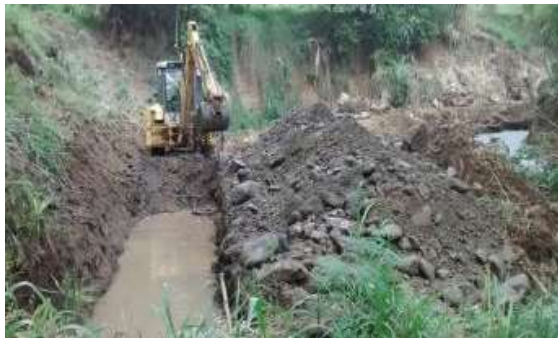
Foto 313 Desviación río y excavación
