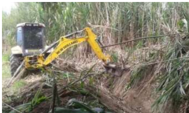
Foto 204 Retroexcavadora aportada por el ingenio Castilla Agrícola para la realización de la actividad, a solicitud de la CVC
