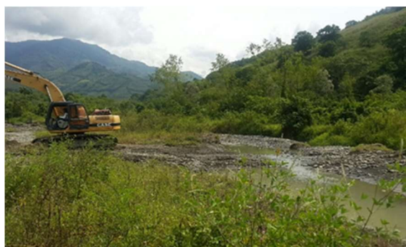
Foto 12. Área de explotación del contrato de concesión CLA 151 y Licencia Ambiental Resolución DG No. 718 de 2005. Materiales de arrastre – Río Cañaveral. DAR Norte
