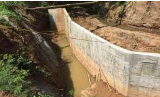
Foto 320 Muro en concreto
