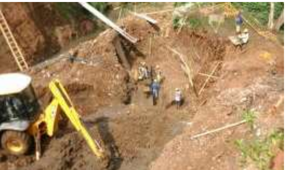
Foto 319 Excavación de muro
