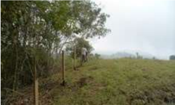
Foto 44. Labores de instalación de aislamientos de protección de áreas naturales en el predio Belmonte, cuenca río Pescador, municipio de Bolívar (diciembre de 2016).
