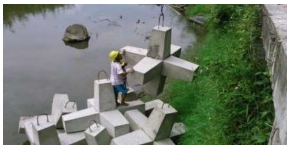
Figura 231. Acorazamiento de la orilla afectada con Hexápodos para mitigar el efecto erosivo de las aguas en dicho tramo del río La Vieja en el sector Guayacanes Municipio de Cartago.
