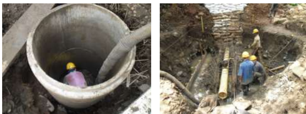
Figura 301. Excavaciones Caisón e instalación de tubería cruce río Cañaveralejo – Proyecto 1820
