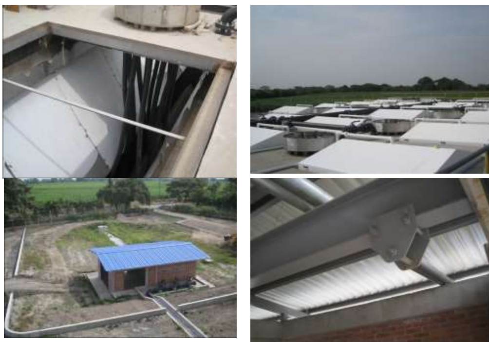
Figura 185. Obras complementarias para el suministro de energía de la PTAR a) Accesorios de acero al carbón y soportes mangueras reactor UASB, b) Reactor UASB con cubiertas instaladas, c) Protección estructura de pretratamiento y bombeo, d) Estructura del malacate para manejar las bombas
