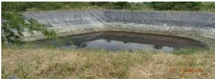
Figura 242. Laguna- Evacuación de lixiviados
