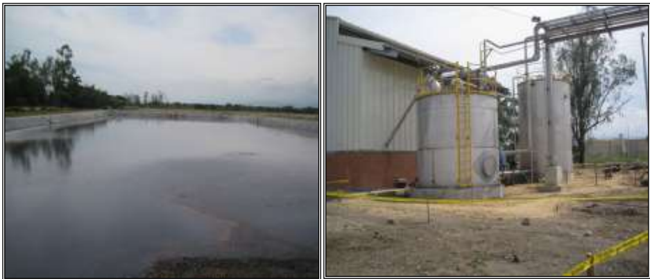
Figura 254. Reservorios de almacenamiento de vinazas tanques de mezcla y almacenamiento de vinazas
