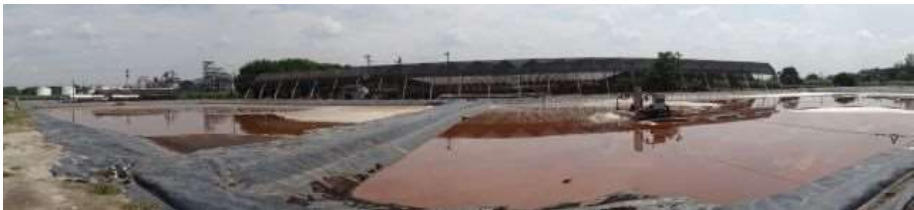
Figura 248. Reservorios de almacenamiento de vinaza – Draga
