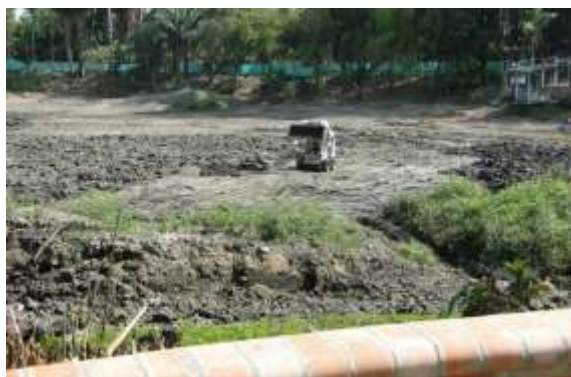
Obras de restauración. Bosque Municipal de Palmira.
