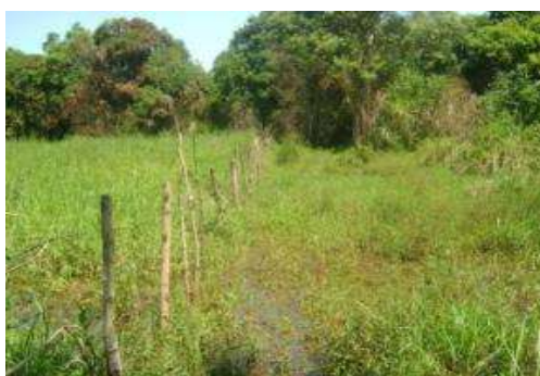
Figura 31. Humeda La Fortuna, limpieza manual de vegetación seca, pastos, juncos, troncos y mecánica de macrófitas acuáticas
