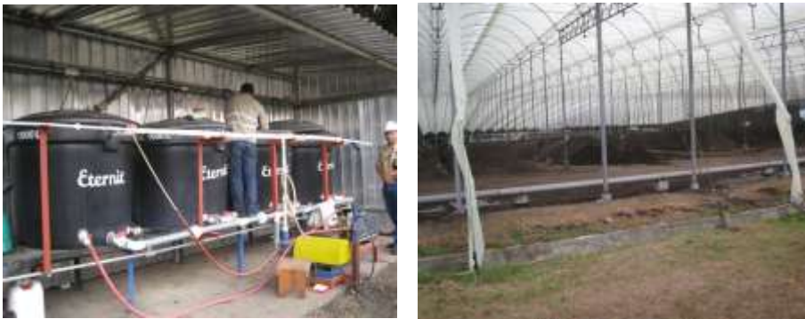
Figura 249. Planta de Biosa y nueva cobertura -Planta de compost, destilería Ingenio Mayaguez
