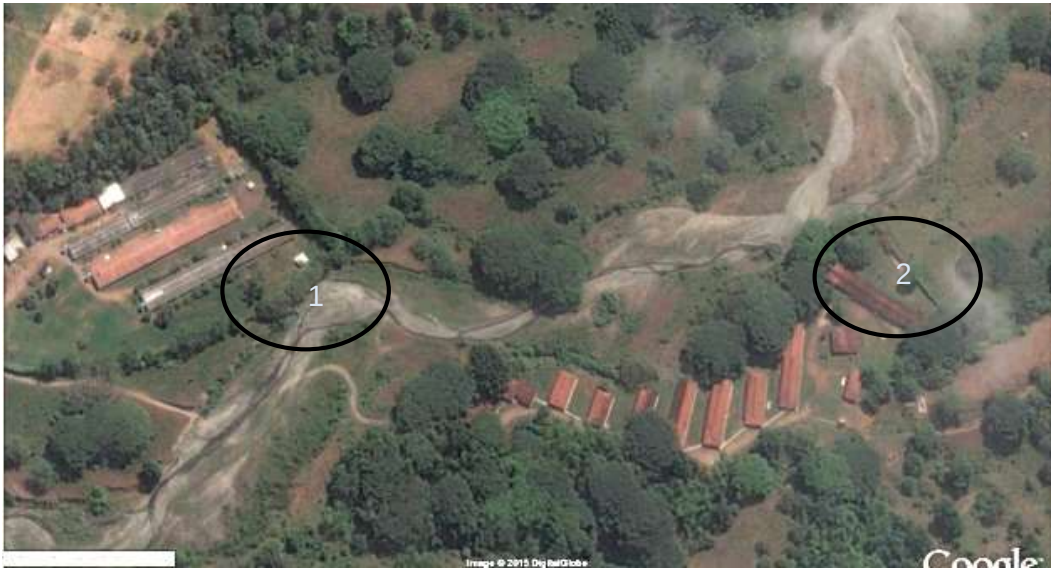
Figura 207. Sectores críticos identificados en el tramo del cauca de la quebrada Artieta Se observan los dos sectores críticos identificados en el tramo del cauce de la quebrada Artieta donde se está generando erosión de los taludes de los predios donde se ubican granjas avícolas - Tomado de Google Earth – Dar Centro Norte
