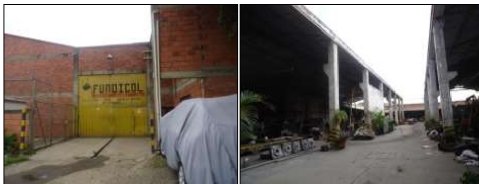
Figura 260. Entrada e interior de la empresa FUNDICOL
