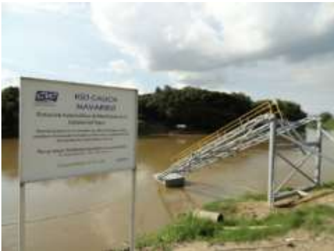
Figura 178. Estación de calidad de agua Cauca-Navarro
