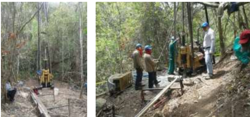
Figura 223. Estudios de Geotecnia realizados en el area del embalse de la Quebrada Vilela/Leona
