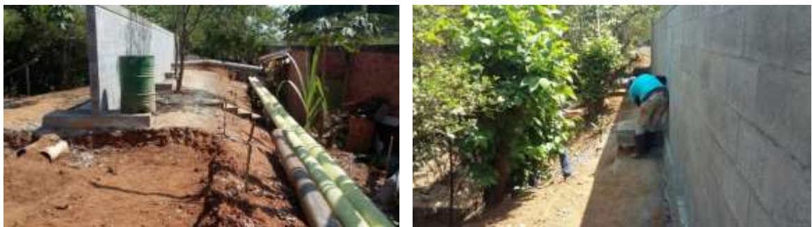
Figura 277. Muro en mampostería estructural en donde se ubica la planta de tratamiento de aguas residuales del Caney
