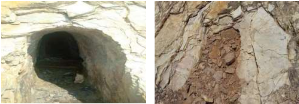
Figura 293.Bocamina clausurada anteriormente utilizada para extracción artesanal de carbón mineral. Fuente: Archivo CVC 2015
