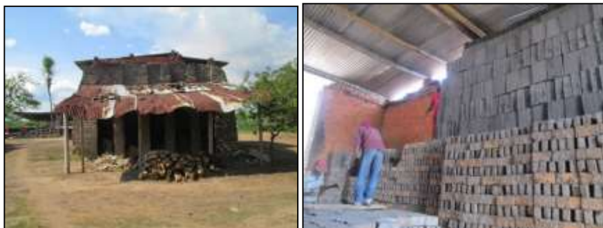
Figura 262. Vista de horno pampa y bodegas de la Ladrillera El Cairo
