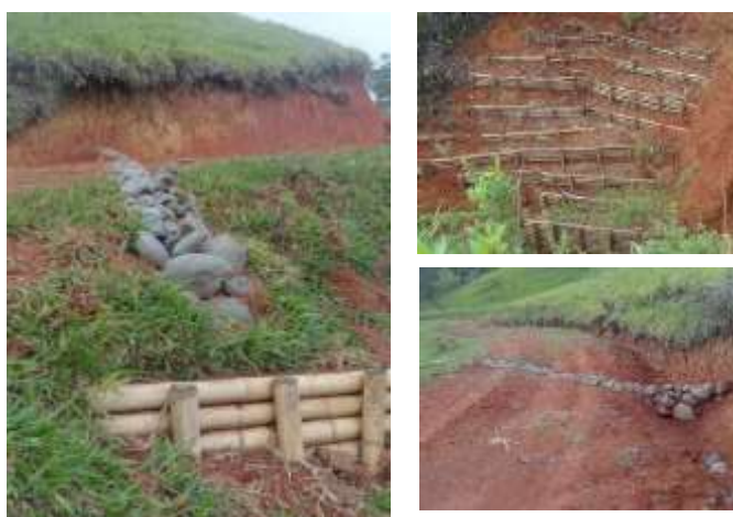
Figura 228. Construcción mejoramiento de las obras de drenajes
