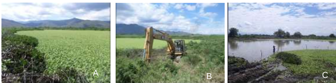
Figura 36. Humedal Cabello Negro, extracción mixta de macrófitas acuáticas a) Antes b)Durante c)Después
