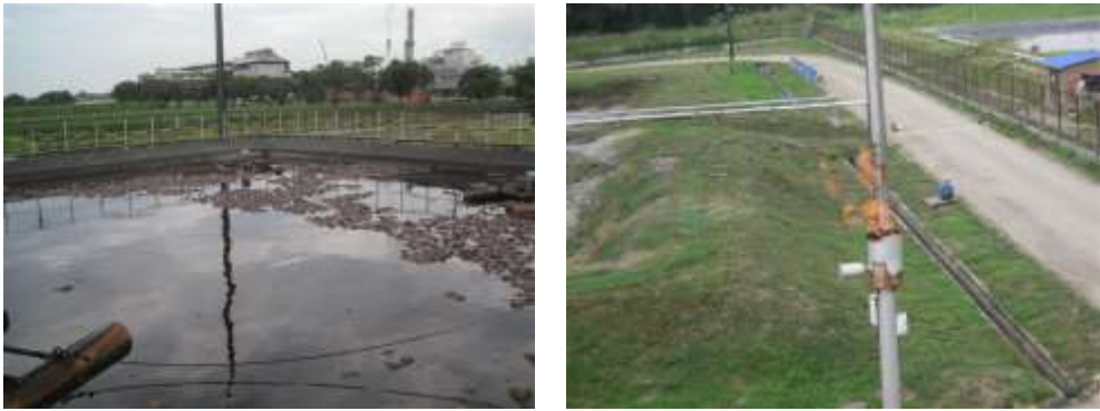
Figura 247. PTAR de Flemazas y condensados Tea para biogás
