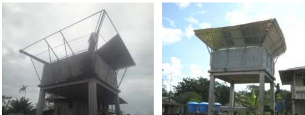
Figura 182. Tanque de almacenamiento de aguas lluvias (Antes y Después). Vereda Cabeceras- Bajo San Juan- Municipio de Buenaventura. Fuente: Archivo CVC 2015
