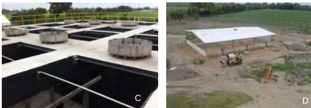
Figura 184. Obras realizadas en la PTAR Candelaria a) Montaje de tuberías -Reactor UASB, b) Escaleras de acceso al reactor UASB, c) cajas de distribución de caudales- Reactor UASB, d) Lechos de secado
