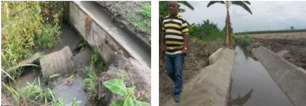
Figura 191. Viaducto de la vereda San José (Antes y Después)
