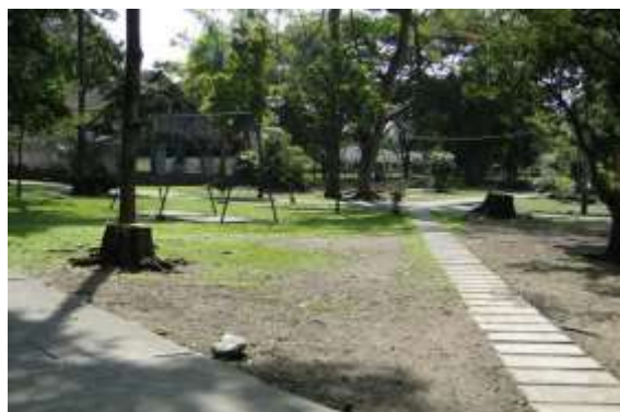
Obras de recuperación de zonas verdes. Bosque Municipal de Palmira
