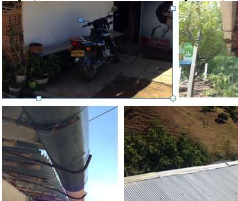
Figura 117: Sistemas para conducción de agua evidenciados en La Unión – Valle; en la vereda El Rincón y La Aguada, cada techo de casa se torna en un área potencial para captura de agua lluvia.
