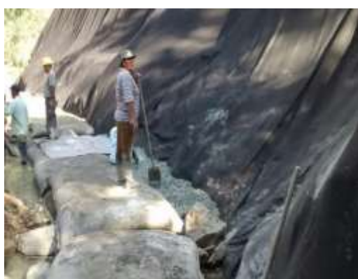
Figura 279. Tramo de construcción muro en Bolsacreto Río Aguacatal
