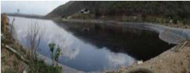
Figura 240. Laguna de contingencia No. 2 - Almacenamiento de lixiviados
