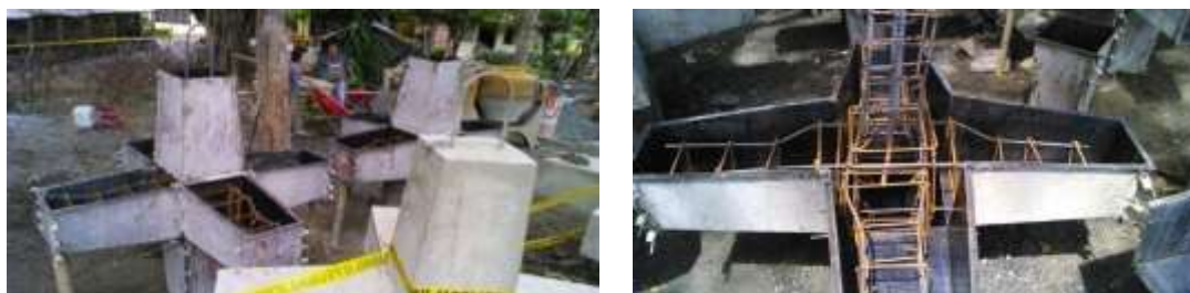
Figura 230. Encofrado para fundición de estructuras proyectadas. Archivo CVC 2015
