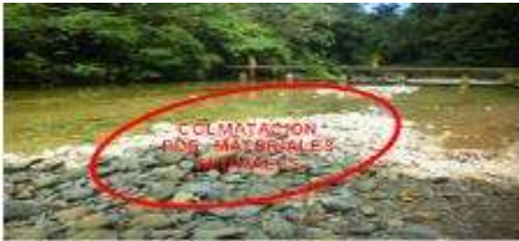
Figura 210. Proceso de colmatación, lo cual perjudica gravemente la operatividad de la planta de tratamiento del acueducto.
