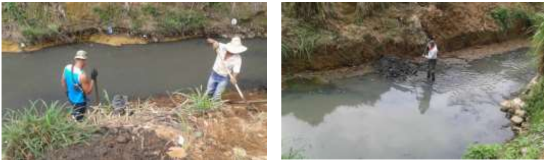
Figura 216. Trabajos de descolmatación y mejoramiento de la capacidad hidráulica de la quebrada San José
