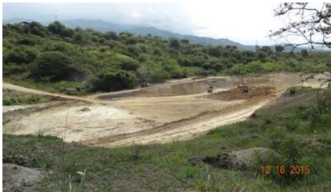
Figura 243. Labores de Adecuación Zona Vaso 3
