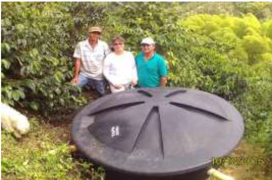
Figura 312. Instalación de un Sistema Hidrolítico Acidogénicos de Flujo Ascendente. Quebrada Los Ángeles. Municipio de Alcalá
