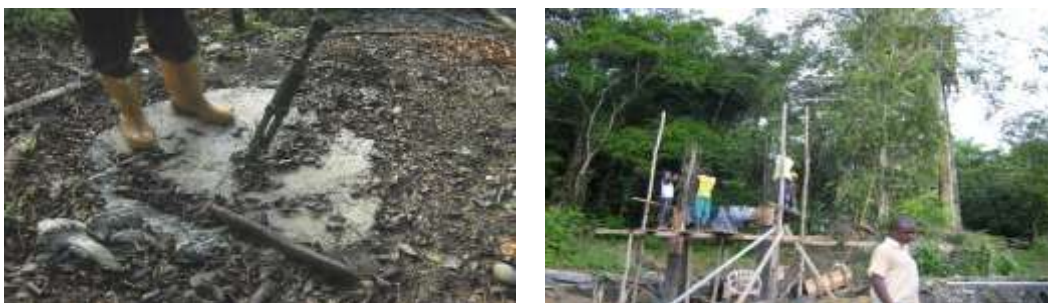
Figura 181. Construcción de viaducto Calle Larga Municipio de Buenaventura – Proyecto 1534 Fuente: Archivo CVC 2015
