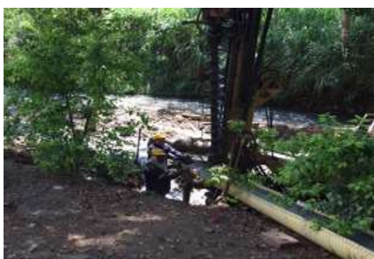
Figura 278. Labores de excavación para construcción de pilotes que soportarán muro de protección en concreto reforzado en el río Lili.
