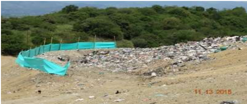
Figura 241. Frente de operación celda 9
