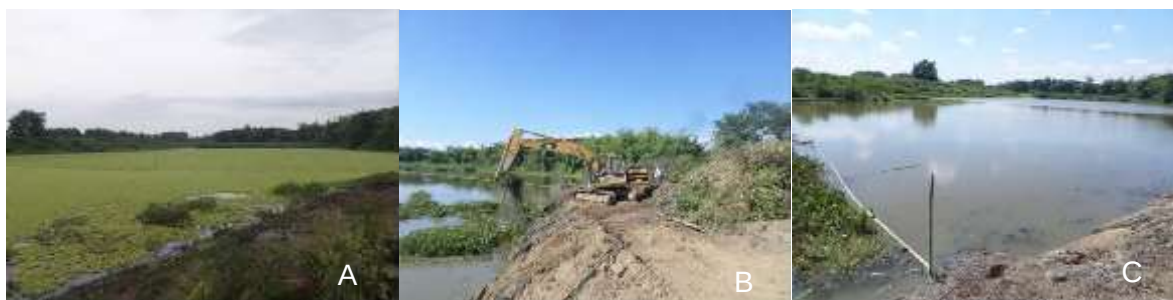
Figura 33. Humedal Bocas de Tuluá, acciones de limpieza. a) Antes b)Durante c)Después
