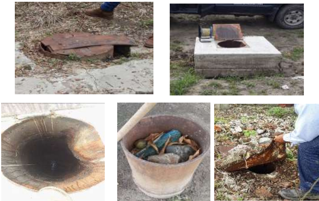
Figura 163. Trabajo de campo para la verificación de las condiciones de los pozos abandonados, requerido para elaborar los conceptos de sellado Fuente: Grupo Recursos Hídricos, DTA. 2015
