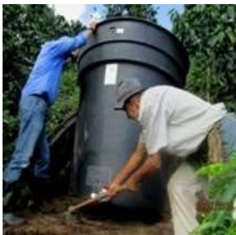
Instalación filtros aguas mieles, quebrada Los Ángeles - Alcalá
