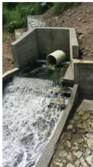
Construcción de Obras
