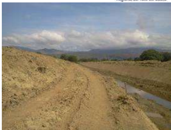
Foto Mejoramiento de la capacidad hidráulica del Caño Nuevo. Archivo CVC. 2015.
