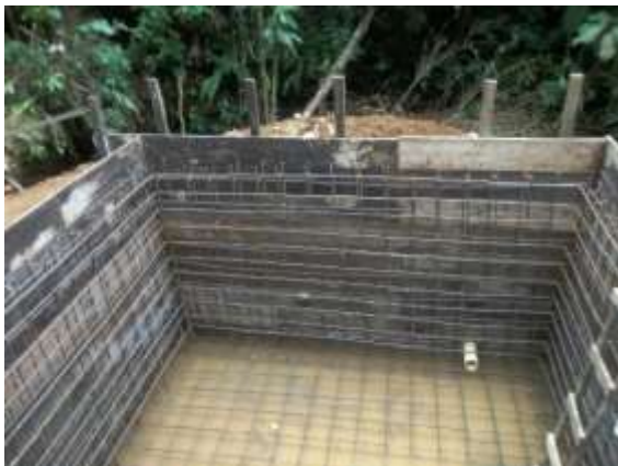
Armado acero de refuerzo doble parrilla. Archivo CVC. 2015.
