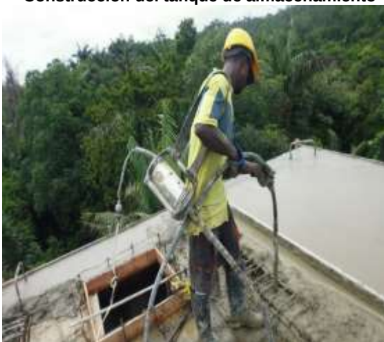
Fundición Losa tanque
