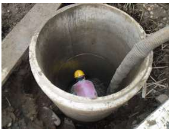
Excavaciones Caisón
