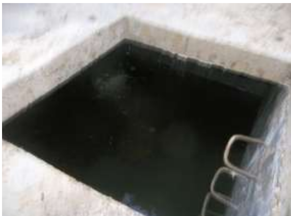
Prueba del tanque. No presento inconvenientes al llenado. Archivo CVC. 2015.
