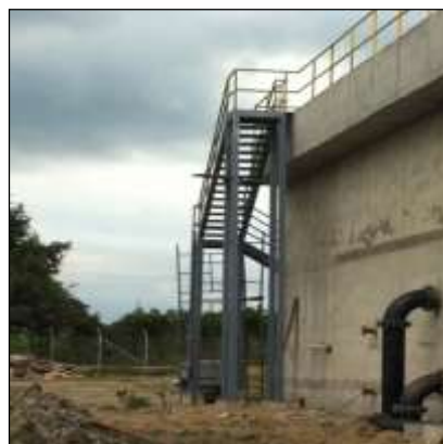
Escaleras de acceso al reactor UASB
