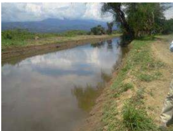
Foto. Mejoramiento de la capacidad hidráulica del Caño Nuevo. Archivo CVC. 2015.
