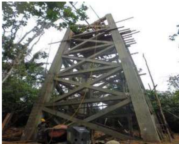
Construcción del tanque de almacenamiento
