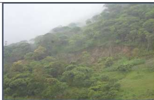
Deslizamiento acueducto los Caleños
