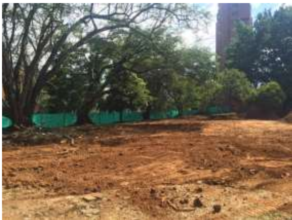
Movimiento de tierra – Zona Biosaludable. Fuente: Contrato de Consultoría CVC No. 464 de 2014.
