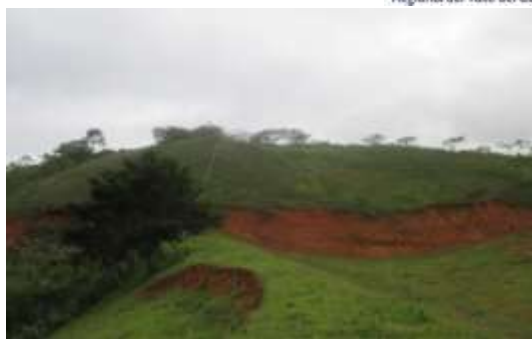
Deslizamiento tipo rotacional en el antiguo reservorio.
