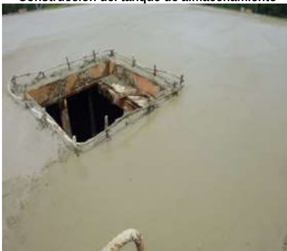
Fundición Losa tanque
