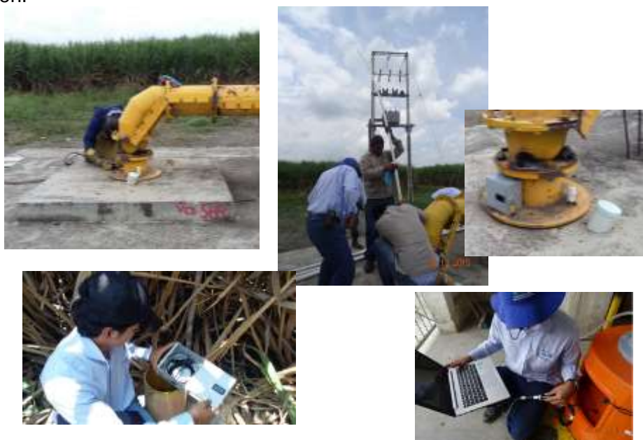
Instalación y descarga de datos de Divers en pozos de monitoreo. Fuente: grupo Recursos Hídricos – DTA – CVC.
