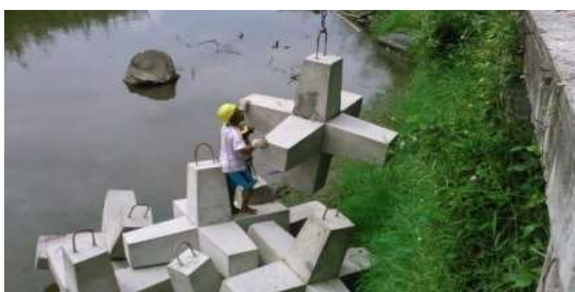
Acorazamiento de la orilla afectada con Hexápodos para mitigar el efecto erosivo de las aguas en dicho tramo del río La Vieja en el sector Guayacanes Municipio de Cartago
