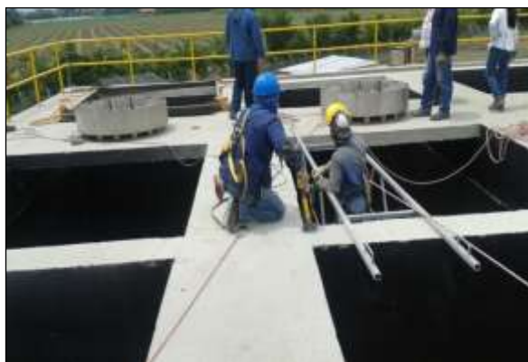
Montaje de tuberías -Reactor UASB
