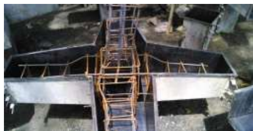
Encofrado para fundición de estructuras proyectadas.
