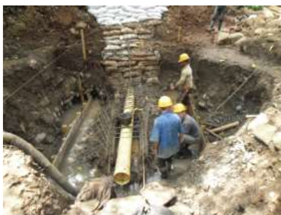
Instalación de tubería cruce río Cañaveralejo
