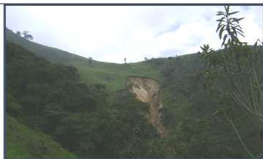
Deslizamiento acueducto San Juanito
