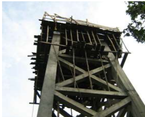
Construcción del tanque de almacenamiento
