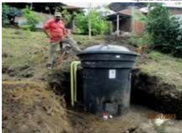
Instalación filtros aguas mieles, quebrada Los Ángeles - Alcalá
