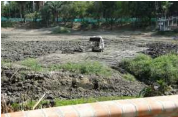
Obras de restauración. Bosque Municipal de Palmira.
