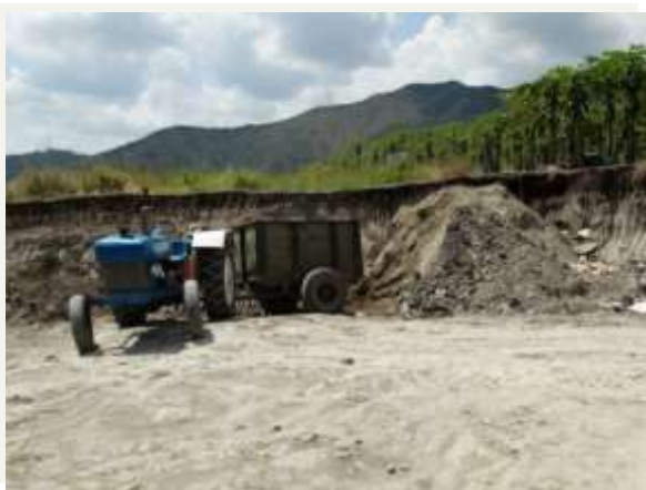
Extracción Arcillas Cgto. Santa Rita Municipio de Roldanillo
