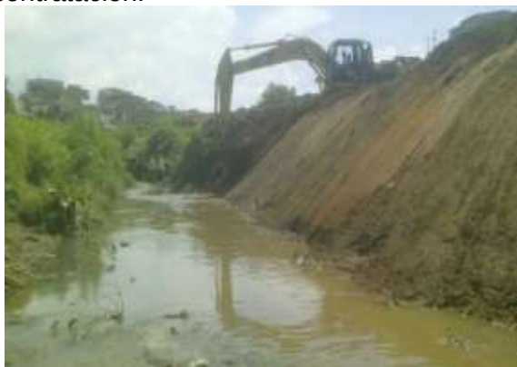
Descolmatación y mejoramiento de la capacidad hidráulica
