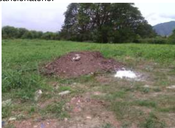
Foto . Adecuación de terreno - Humedal Pelongo
