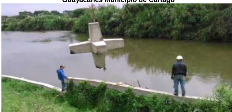
Izaje de Hexápodos mediante grúa telescópica para ser instalados sobre orilla afectada.
