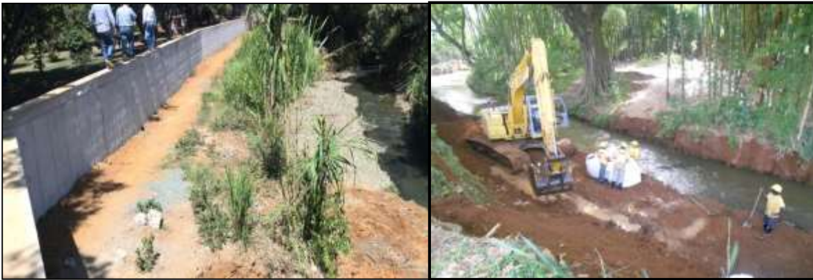
Muro construido en la ciudadela COMFANDI
