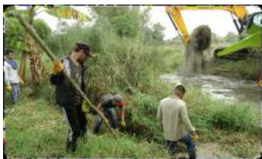
Foto. Limpieza mecánica Humedal Timbique – Predio Blanca Flor
