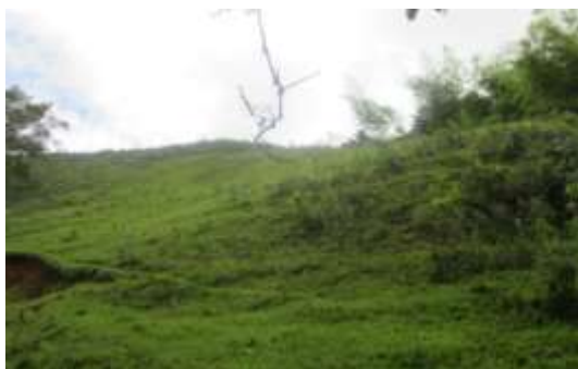
Procesos erosivos (reptación) en inmediaciones de la bocatoma.
