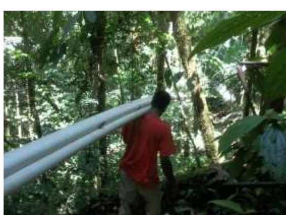
Carga de tubería para instalación. Archivo CVC. 2015.
