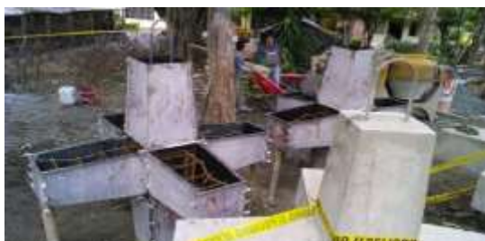
Encofrado para fundición de estructuras proyectadas.
