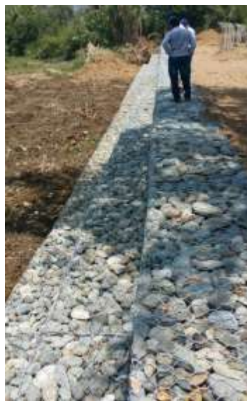
Construcción de Obras
