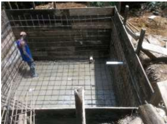
Armado acero de refuerzo primera parrilla. Archivo CVC. 2015.
