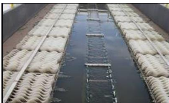
Foto 146. Cambio de placas en el UASB- Ingenio Riopaila
