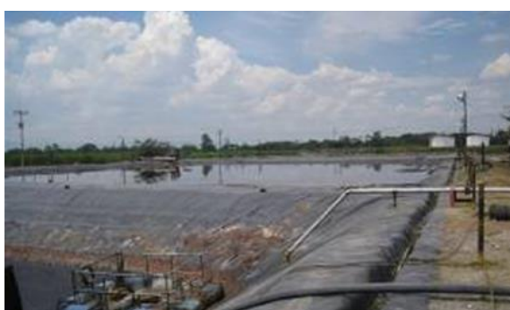
Foto 142. Lagunas de almacenamiento de vinaza- Ingenio Mayagüez
