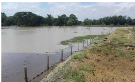
Foto 180. Dique de Guare - Corregimiento de Guare-Municipio de Bolívar. Archivo CVC 2017
