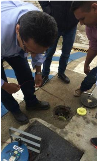
Foto 41. Trabajo de campo para la localización de pozos de monitoreo.
