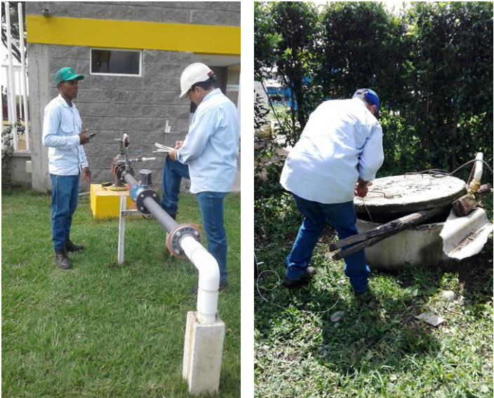
Foto 43. Trabajo de campo para apoyar la elaboración de los conceptos de concesión de aguas subterráneas. Fuente: Grupo Recursos Hídricos, DTA. 2017
