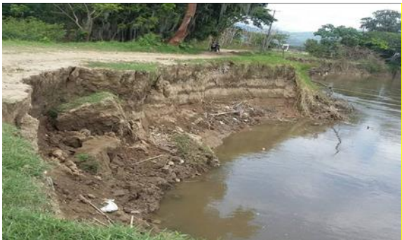
Foto 169. Estado de avance del proceso erosivo sector contiguo a la “Y” Predios La Isabela y Bello Horizonte. DAR Centro Sur. Archivo CVC 2017
