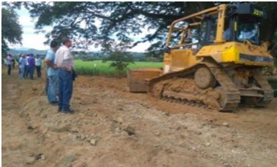
Foto 188. Reparación dique San Pedro –La Victoria. Archivo CVC. 2017
