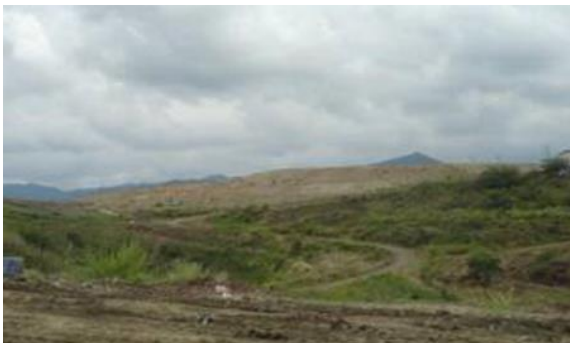
Foto 138. Frente de operación obras clausura celda 9 – Relleno Sanitario Presidente
