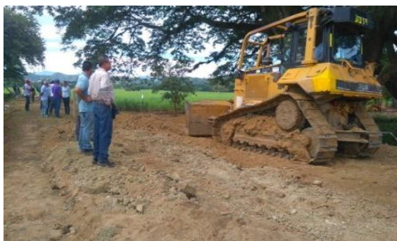
Foto 178. Reparación dique San Pedro. DAR BRUT. Archivo CVC 2017
