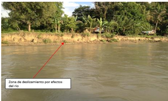
Foto 173. Afectación en la comunidad de Puerto Merizalde río Naya. Archivo CVC 2017
