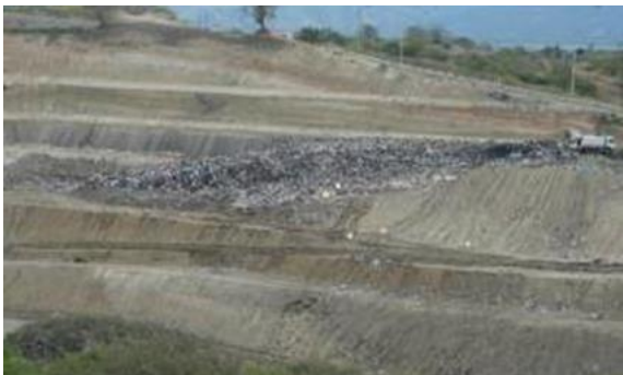
Foto 137. Frente de operación obras clausura celda 9 – Relleno Sanitario Presidente
