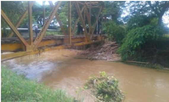
Foto 187. Puente Rio La Paila. Archivo CVC. 2017
