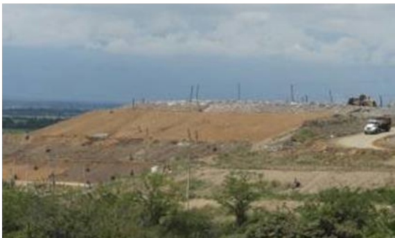
Foto 135. Disposición actual vaso A5- Relleno Sanitario Colomba El Guabal
