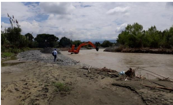
Foto 176. Labores de descolmatación del río Tuluá a la altura del puente papayal, Foto Gregorio Mondragón. Archivo CVC 2017
