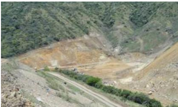
Foto 136. Proceso constructivo vaso A7- Relleno Sanitario Colomba El Guabal
