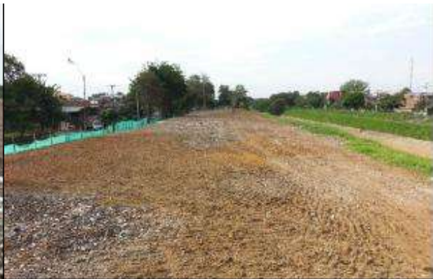
Área libre de escombros
