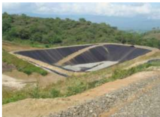
Avance construcción celda de seguridad
