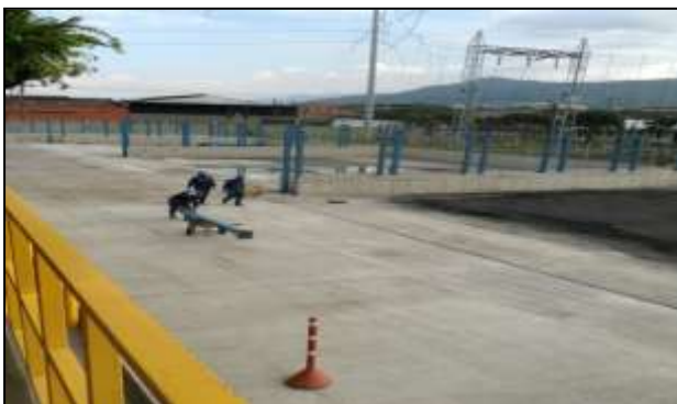
Construcción de centro de acopio de almacenamiento de residuos y recuperación de parte metálica para peligrosidad
