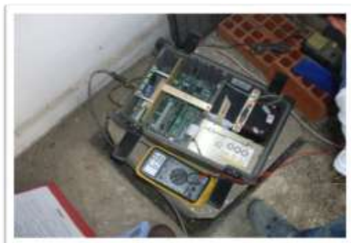
Estación Hospital Universitario antes
