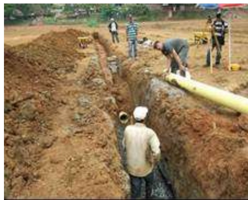
Instalación de tubería y tapado de zanjas
