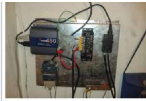
Estación Hospital Universitario después
