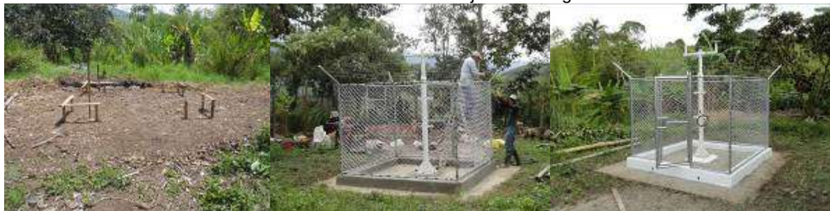
Estación hidrométrica Ovejas - Dos Aguas
