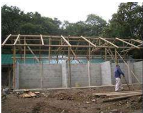
Módulos de reciclaje en construcción
