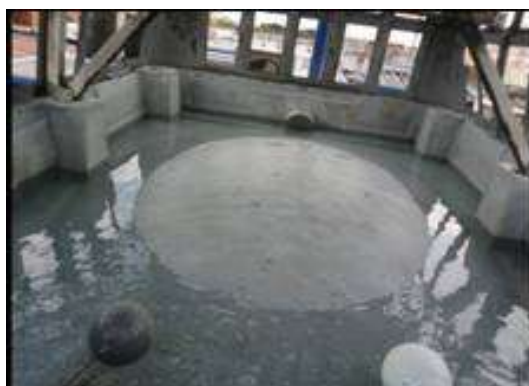
Mantenimiento torres de enfriamiento CVC Edificio principal
