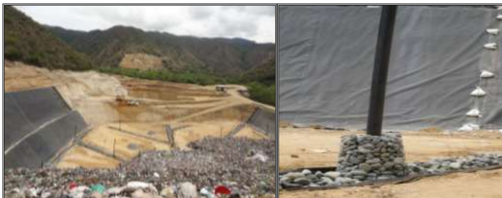
Adecuación del vaso C- Celda C2T2.
