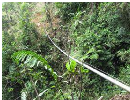
VIADUCTOS EN TUBERIA GALVANIZADA
