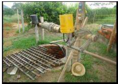
Construcción aljibe (profundidad: 14 m). Sede de La Unión en el BRUT
