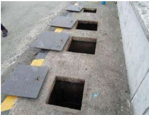
Trampa de grasas y tanque séptico estación de Servicio Terpel Buenaventura
