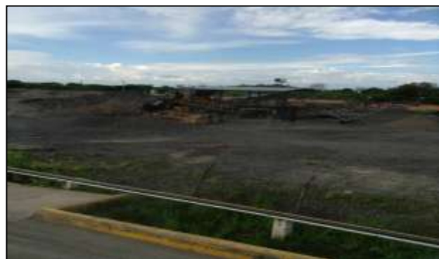
Diaco cuenta con la planta de proceso de clasificación temporal de residuos procesados y análisis de aprovechamiento en la siderúrgica
