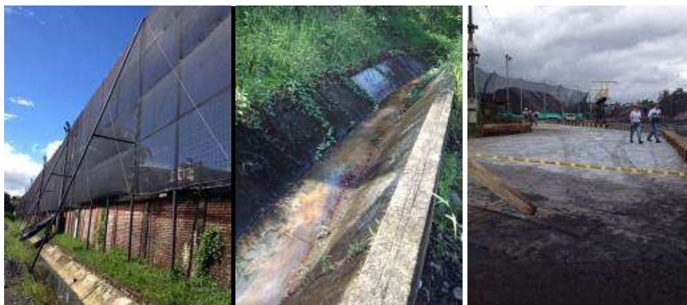
Construcción de infraestructura para patios de carbón
