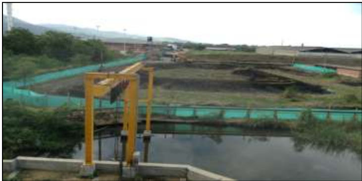
Construcción de celda de seguridad. Actualmente se realiza adecuación del suelo, y se han construido cinco (5) piezómetros para monitoreo de nivel freático y calidad de las aguas subterráneas.
