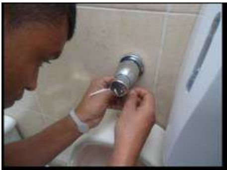
Instalación de Orinales Ecológicos en el Edificio Principal
