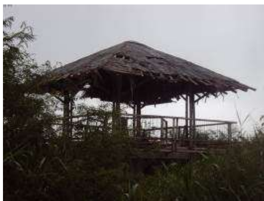
TRABAJOS DE LIMPIEZA
