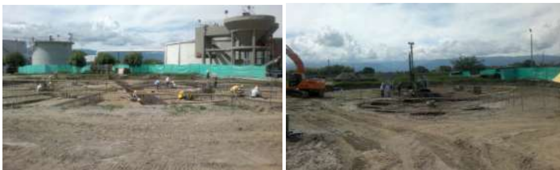
Cimentación para Filtro Percolador y piloteo para cimentación de Clarificador PTAR Tuluá
