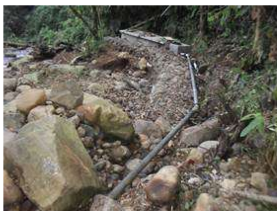
BOCATOMA EN FUNCIONAMIENTO TUBERIA GALVANIZADA ADUCCION Y DESARENADOR
