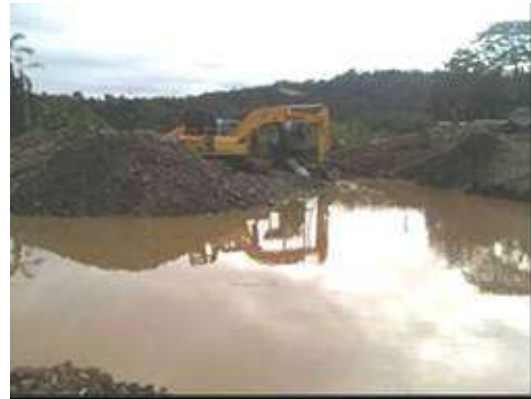
Socavamiento y desestabilización de suelos en las zonas intervenidas con remoción de la cobertura vegetal en las márgenes forestales protectoras.
