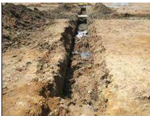
Apertura de zanjas
