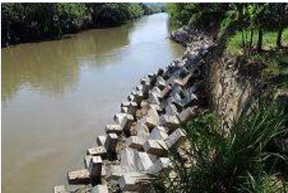
Hexápodos y Obras de fijación de orilla de la margen izquierda del río La Vieja
