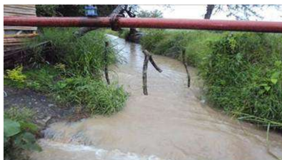
Canal de conducción para el acueducto municipal, a su máxima capacidad, sin presentarse desbordamientos.
