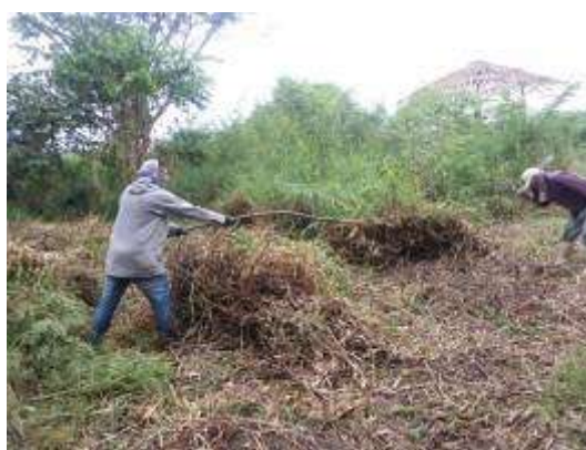
DESMONTE DE ELEMENTOS EN MAL ESTADO
