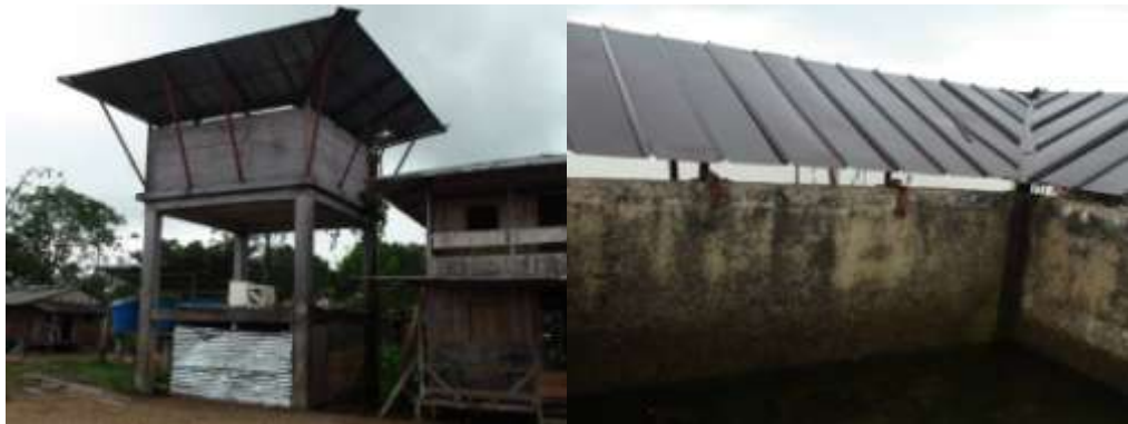
Estado actual del tanque de almacenamiento.
