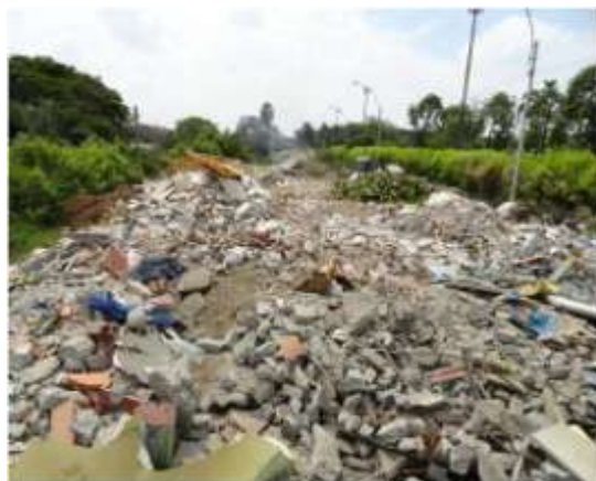
Estado actual de la escombrera ilegal
