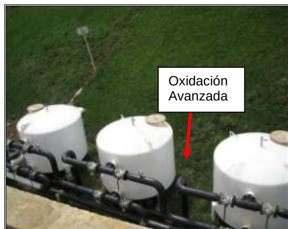
Tanques de aireación y oxidación avanzada y filtros de carbón activado y arena
