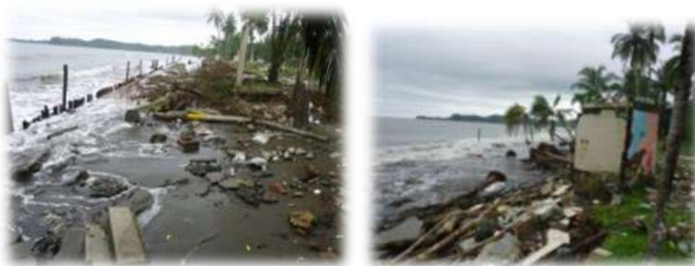
Recorrido en la comunidad de La Barra, Bahía Málaga para monitorear con el equipo técnico del INVEMAR, los efectos causados por el mar sobre las playas y acantilados (erosión costera), realizar los perfiles de playa y tomar el avance de la línea de playa en el área.
