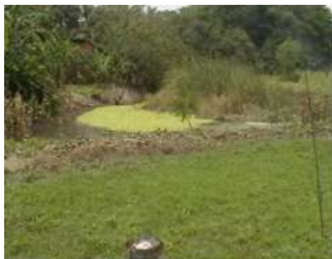
Brazo del humedal Timbique en el Predio La Palma con aumento de volumen de agua por vertimiento de aguas de la derivación No. 8 y estancamiento de las mismas por construcción de sitios de paso sobre cauce del brazo del humedal
