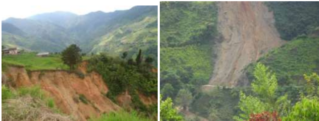
Cárcava Montebello Municipio El Águila Cárcava Cairo El Edén vereda llano Grande
