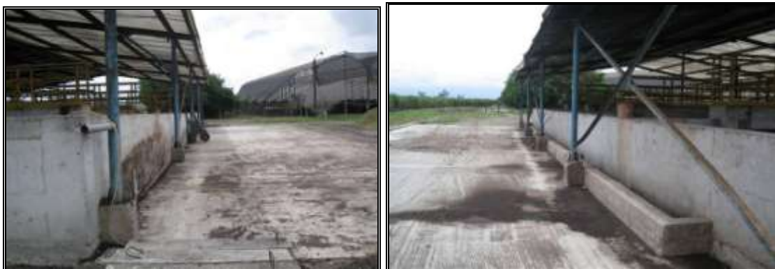
Adecuación alrededores lechos de secado
