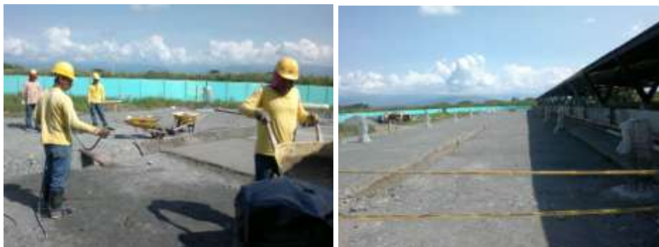
Pilotes y Fundición de solado de limpieza en Lechos de Secado PTAR Tuluá
