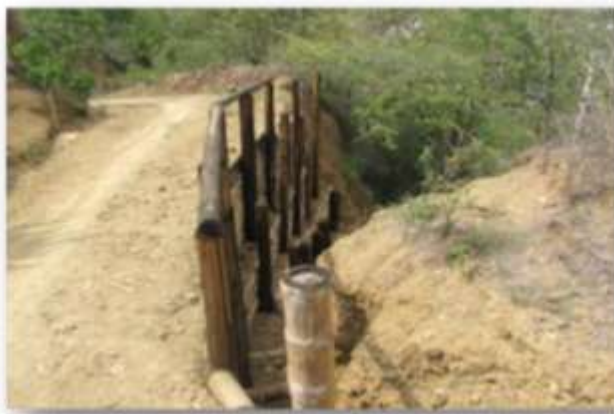
Panorámica de trabajos de estabilización de suelos con obras bioingeniería, vía a Santa Maria, Cárcava Chicharronal, Municipio de Dagua. Foto tomada por Jefferson Orejuela, Marzo5 de 2013
