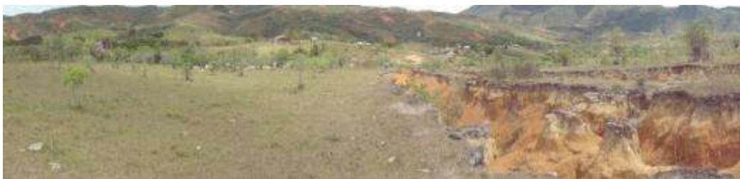
Panorámica afectación de suelos, vereda Río Grande, municipio de Restrepo. Foto tomada por Jefferson Orejuela. Enero 30 de 2013
