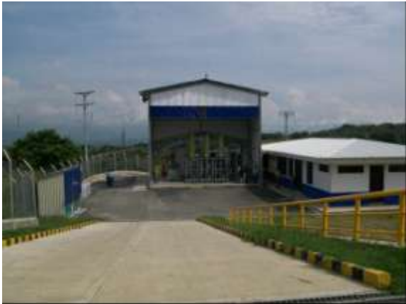
La capacidad para tratar lixiviados es de 3 l/s.
