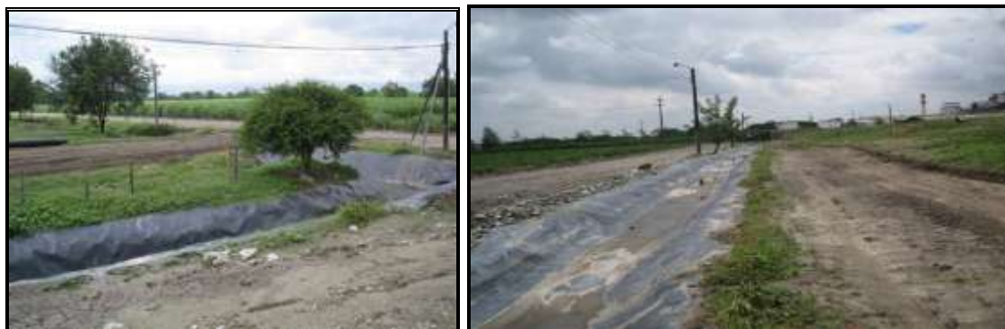
Canales de aguas lluvias impermeabilizados
