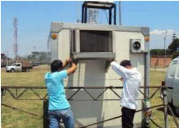
Adecuación y mantenimiento de las cabinas
