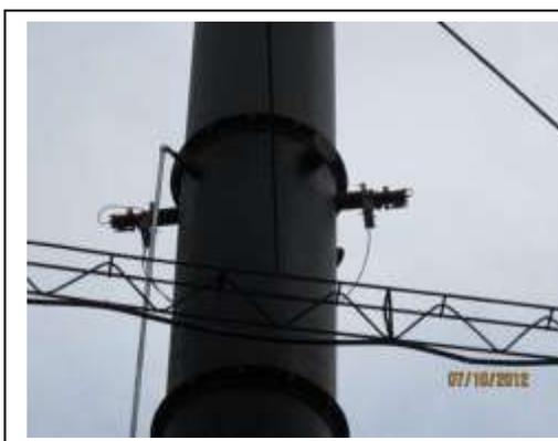
Sistema de monitoreo continuo de gases, Caja de control y opacímetros ubicados en chimenea
