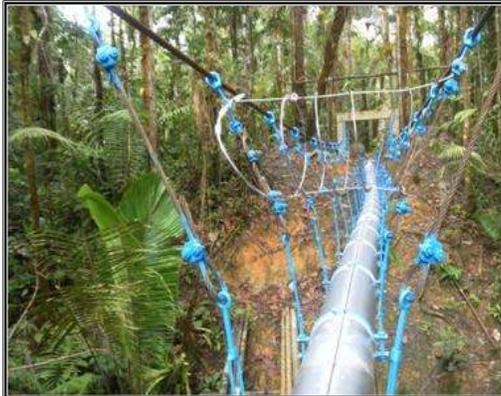
PASOS AÉREOS (VIADUCTOS) Concertina instalada en el Viaducto 34 para evitar que se suban sobre la tubería
